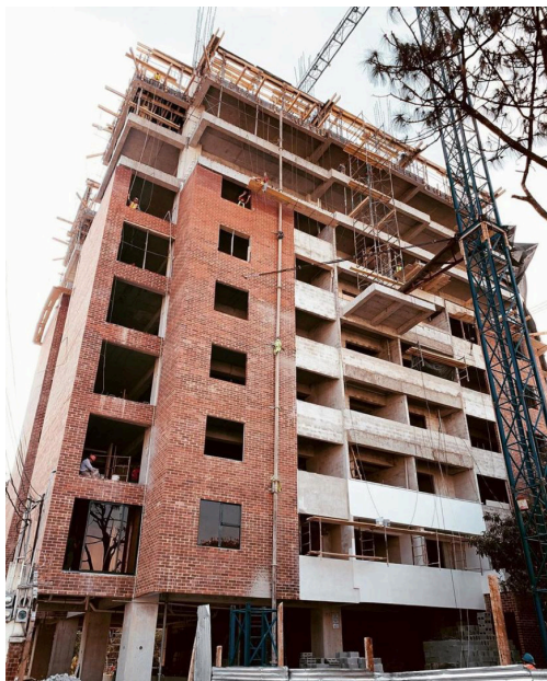
Figura 112. Estructura secundaria, cerramientos con ladrillo y block.
