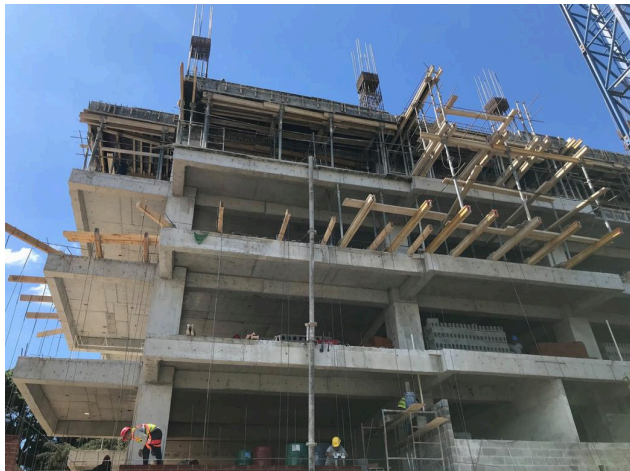
Figura 110. Estructura portante, columnas, vigas principales, vigas secundarias para los voladizos y losas de concreto.
