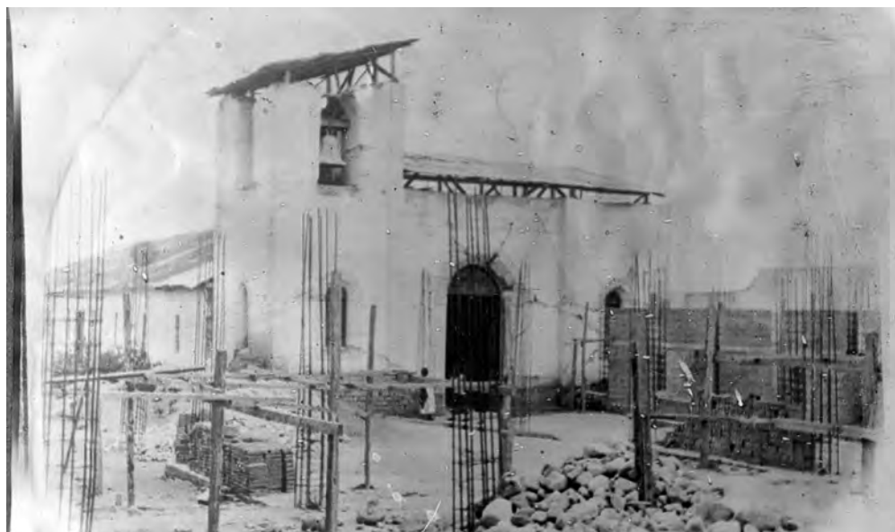
Ilustración 23. Fotografía de 1954, muestra el templo parroquial entre 1906 y 1951 deteriorado por el terremoto de 1942 y se observa los cimientos de la actual construcción. Fotografía de colección privada.
