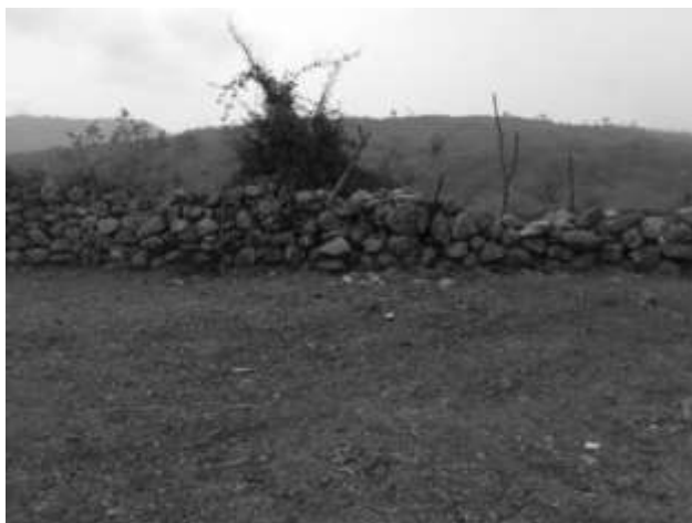
Figura 12. Reutilización de las piedras de los basamentos para cercos, Fotografía Ch. Martínez.
