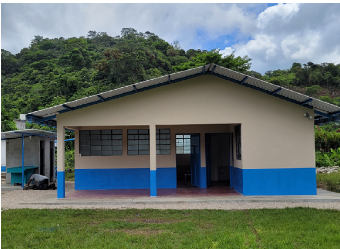
Figura 34: Exterior del Puesto de salud Ixquis | Crédito: equipo consultor.
