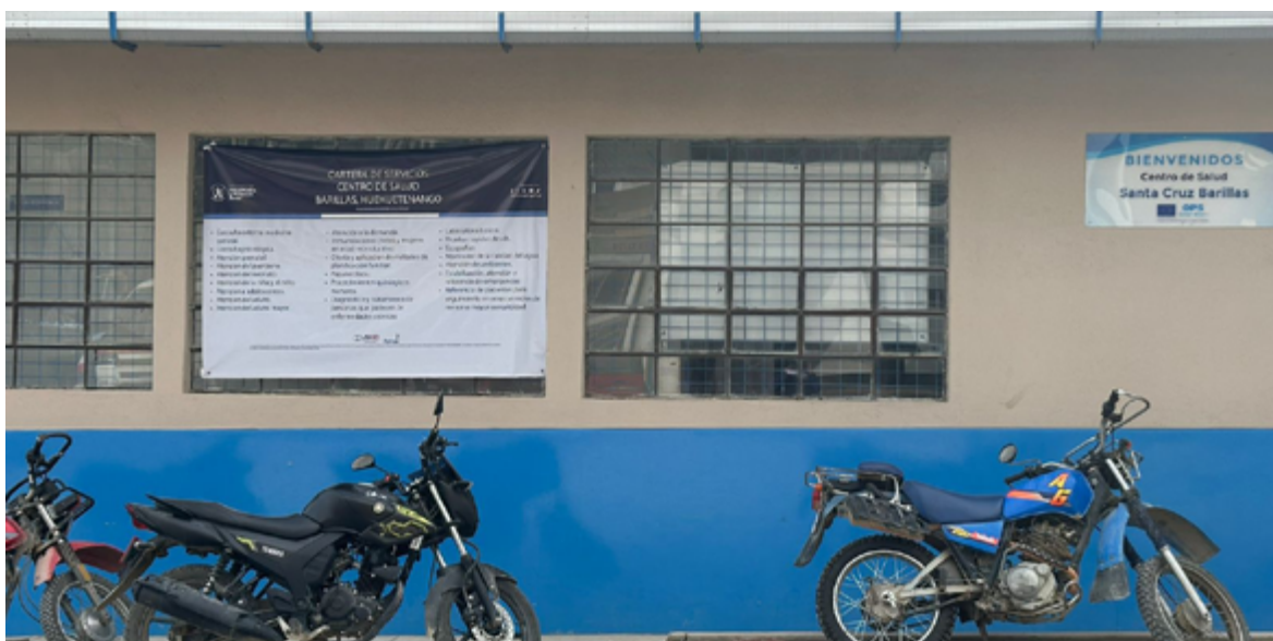
Figura 4: Fachada del Centro de salud Santa Cruz Barillas | Crédito: equipo consultor.
