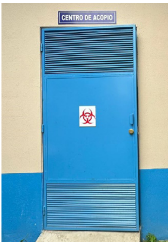
Figura 15: Puerta del centro de acopio del Puesto de salud Nucá | Crédito: equipo consultor.
