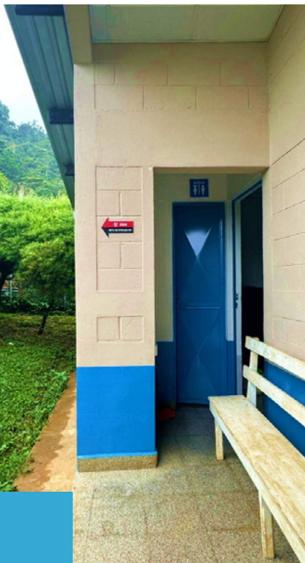
Figura 34: Señalización de la ruta de evacuación de DSH en el Puesto de salud Ojo de Chancolín | Crédito: OPS/OMS.
