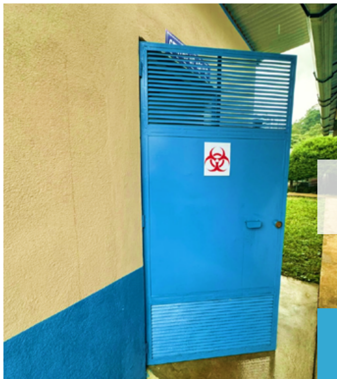
Figura 33: Entrada señalizada al centro de acopio del Puesto de salud Ojo de Chancolín | Crédito: OPS/OMS.
