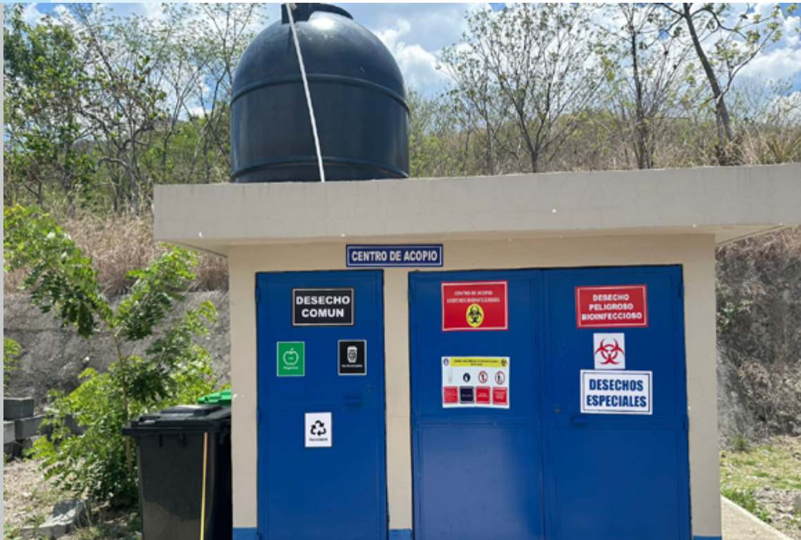
Figura 32: Centro de acopio temporal de DSH (con rotulación adecuada, acceso a agua y segmentación de desechos) del Centro de atención permanente Jocotán | Crédito: Equipo consultor.
