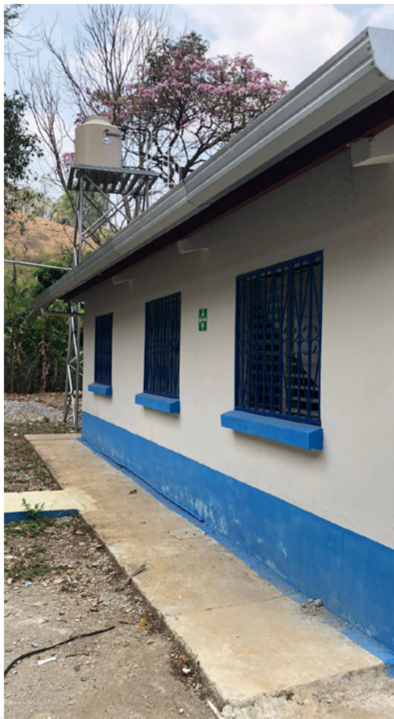
Figura 6: Área exterior del Puesto de salud Encuentros | Crédito: equipo consultor.
