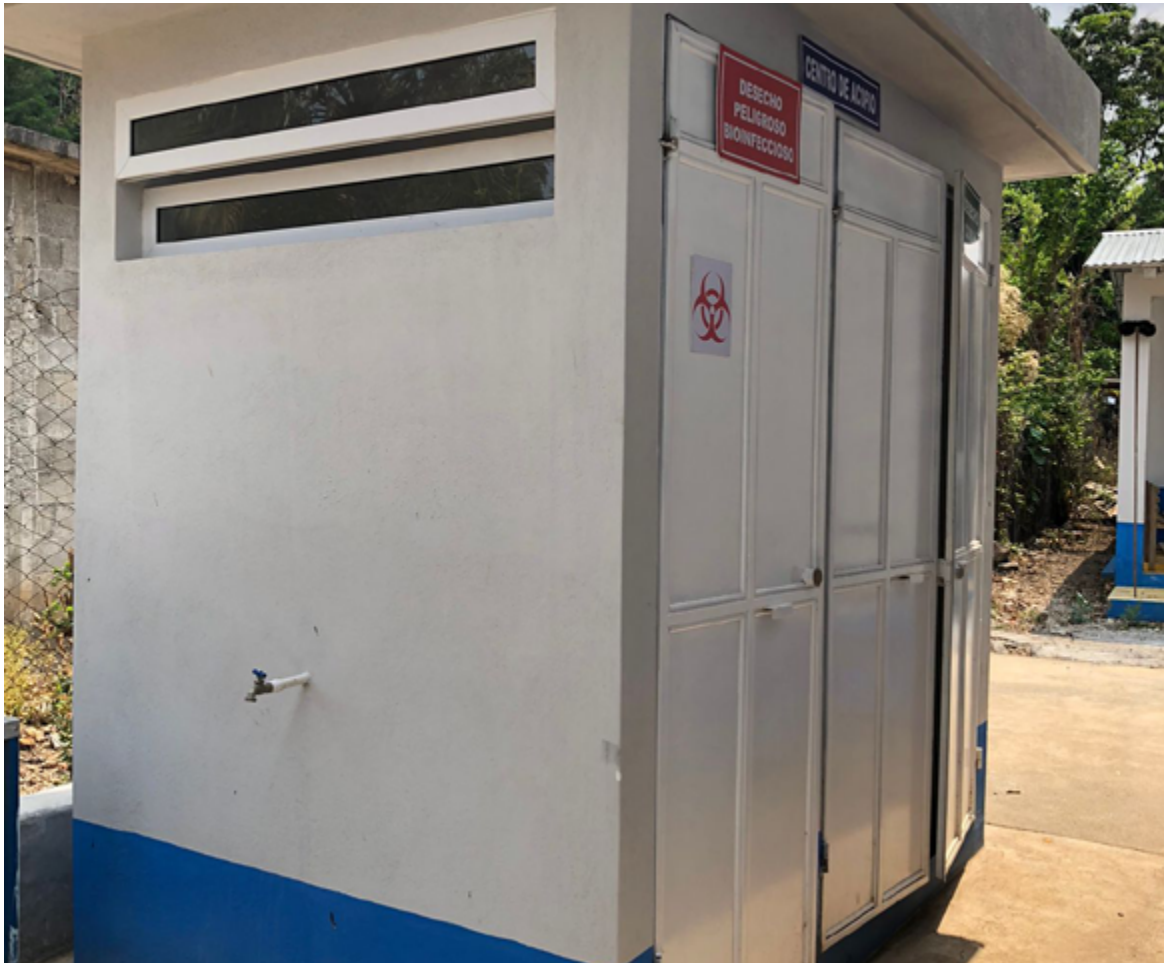
Figura 35: Exterior del centro de acopio del Puesto de salud Encuentros | Crédito: equipo consultor.
