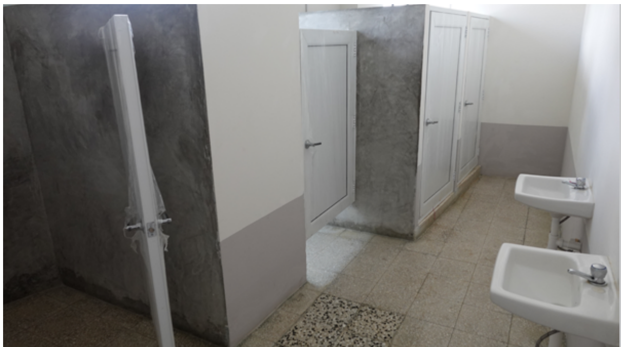
Figura 35: Servicios sanitarios restaurados del Centro de atención permanente San Juan Chamelco por el proyecto | Crédito: Equipo consultor.
