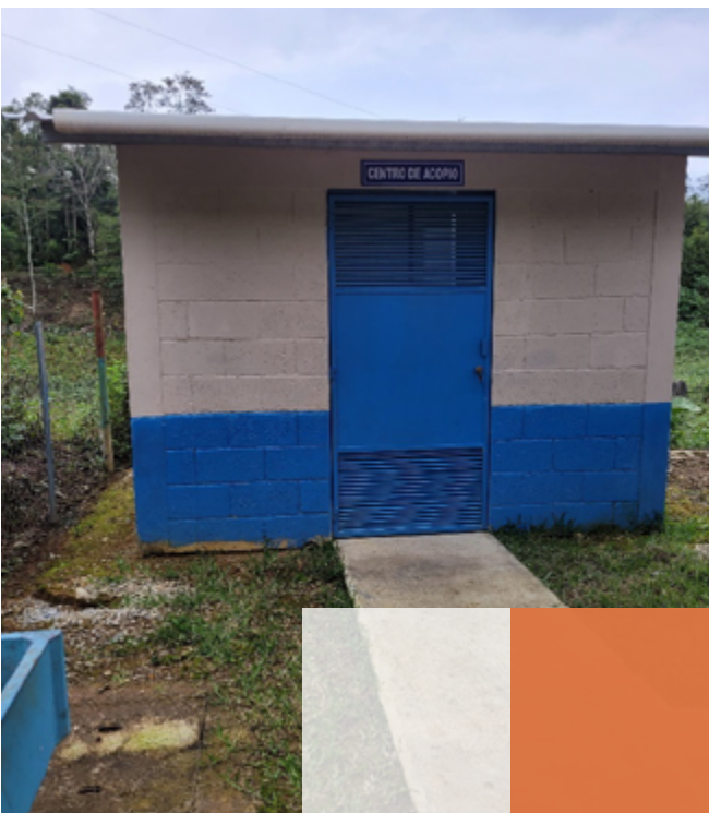
Figura 10: Exterior del centro de acopio del Puesto de salud Saxoc | Crédito: equipo consultor.
