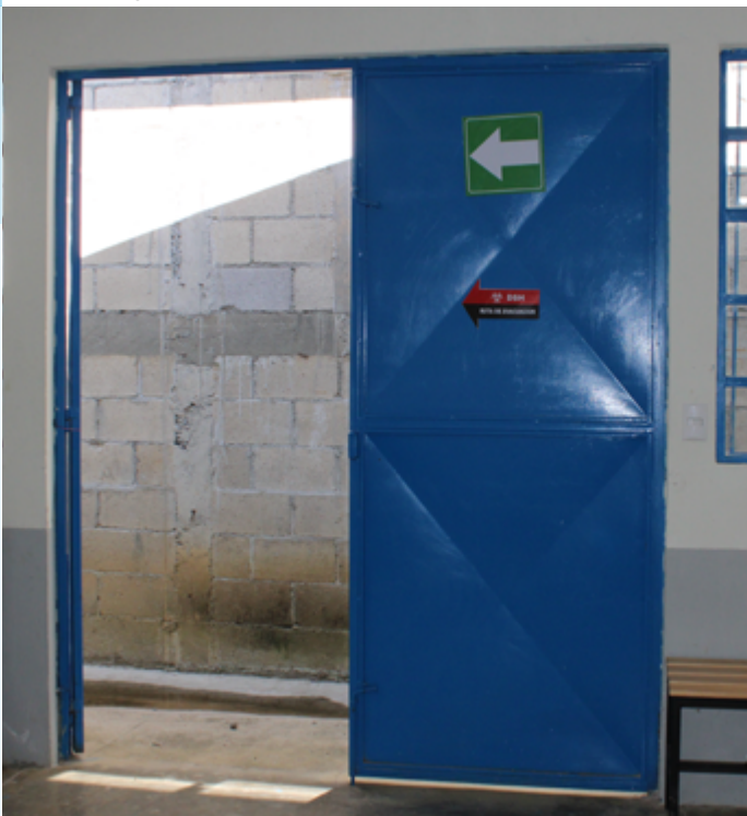
Figura 8: Señalización de ruta de evacuación DSH | Crédito: OPS/OMS.
