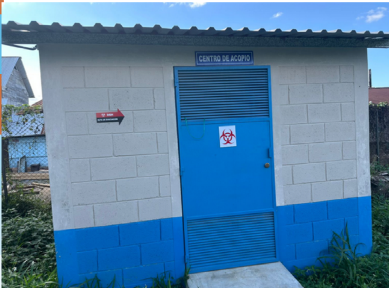
Figura 32: Centro de acopio del Puesto de salud Salacuim | Crédito: equipo consultor.
