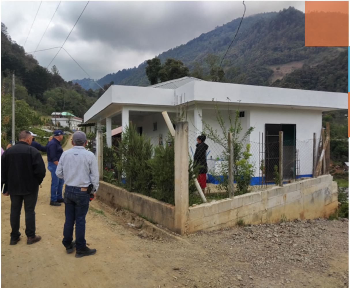
Figura 6: Exterior del Centro comunitario de salud Xoloché | Crédito: equipo consultor.
