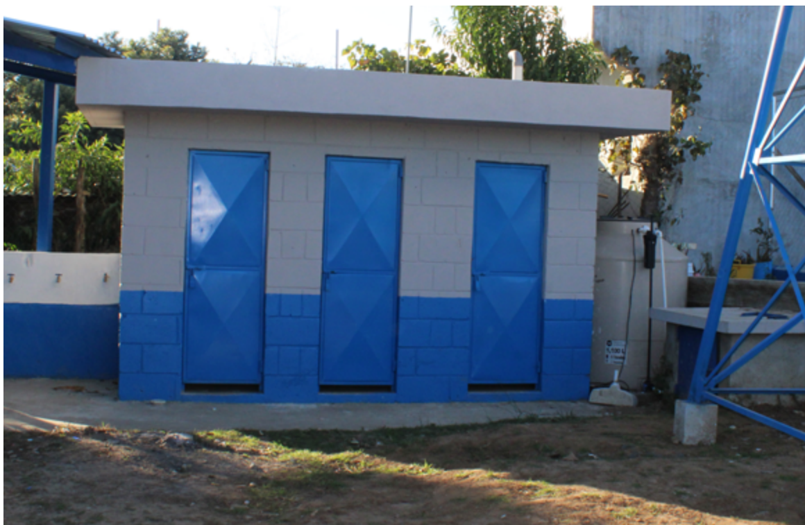
Figura 32: Centro de acopio del Centro comunitario Vipecbalam en remodelación | Crédito: equipo consultor.
