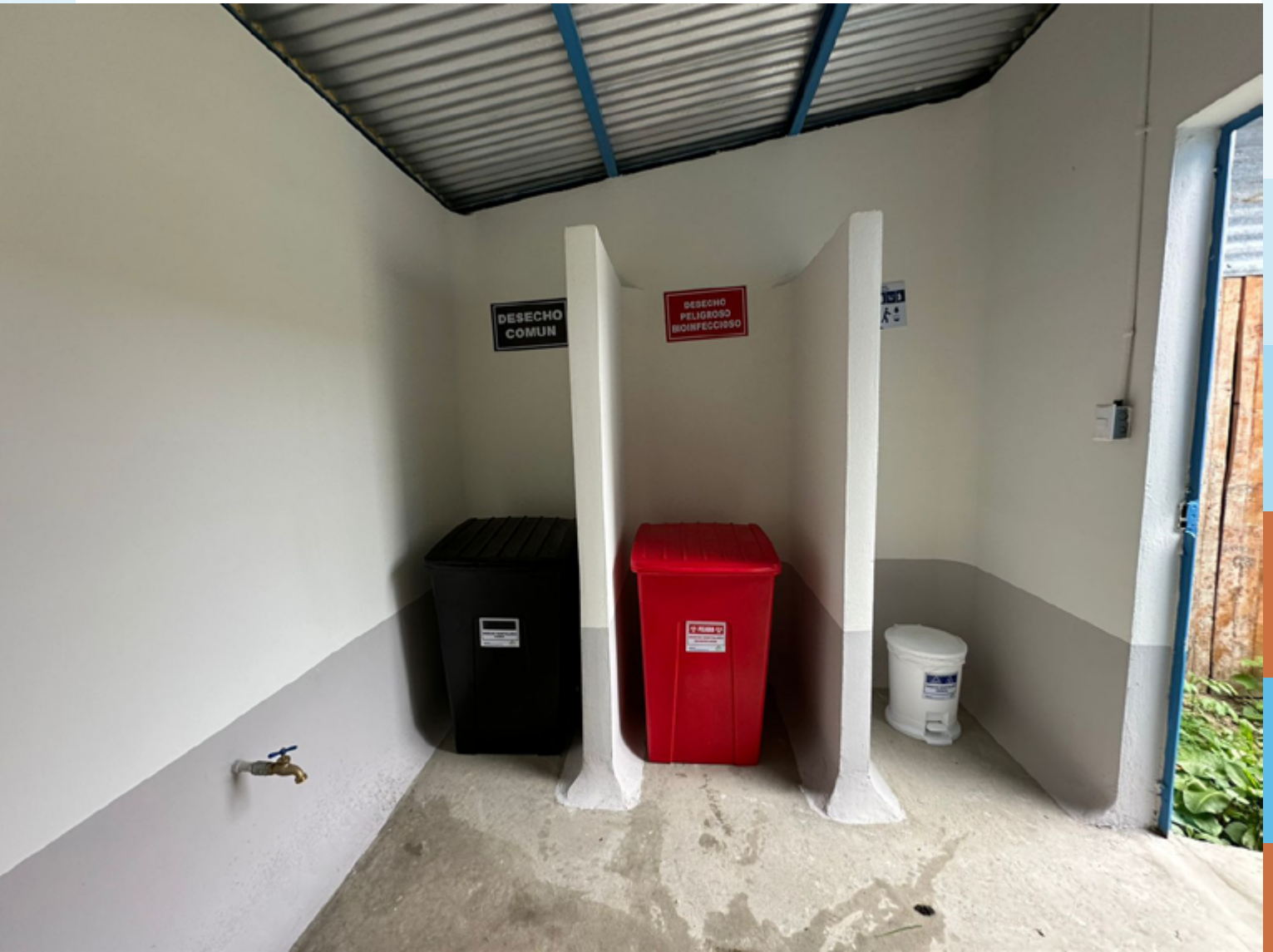
Figura 34: Vista interior de centro de acopio temporal del Centro de salud Camontán, con división de áreas, grifo, drenaje y ventilación natural, evaluado por el proyecto para mejora de servicios | Crédito: equipo consultor
