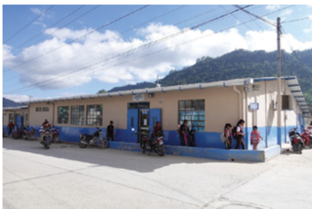
Centro de Salud, Barillas, departamento de Huehuetenango rehabilitado. Primer bloque de 24 establecimientos finalizados. Año 2024
