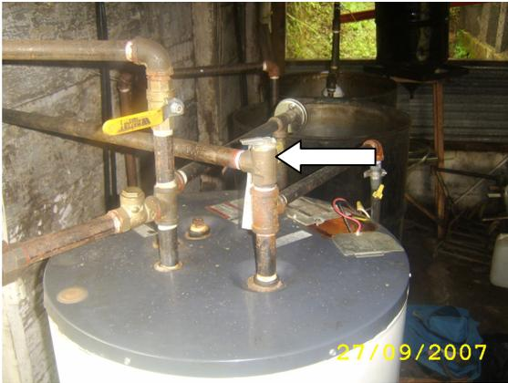
Paso 9: Este no es exactamente un paso a realizarse sino solo una medida de seguridad que tiene el sistema en esta parte del reactor por si el sistema excediera la presión dentro del reactor y utiliza una válvula de seguridad de 20 libras de presión.
