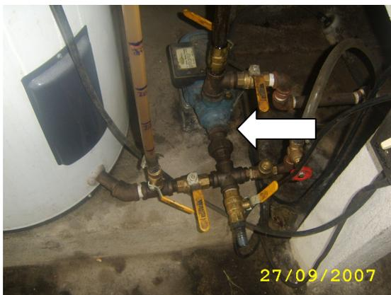
Paso 8: Se mezcla el metóxido de sodio con el aceite vegetal usado empleando la bomba 3 durante una hora y media.
