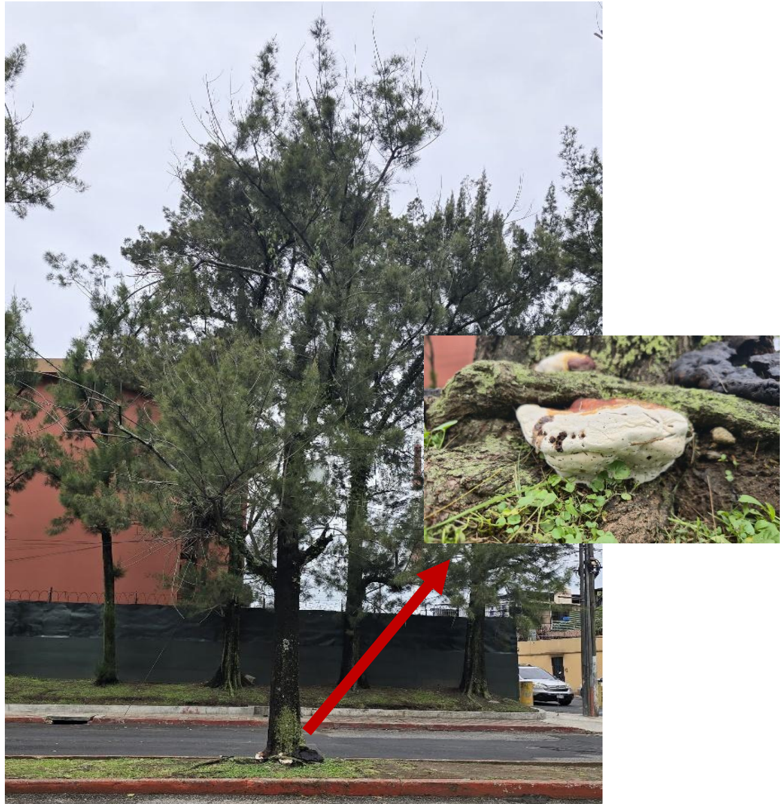
Figura 10. Casuarina sp. del arbolado urbano con infección activa por Ganoderma spp. Se observa el hospedante en pie y, en detalle, la presencia de carpóforos desarrollados en la base del fuste (flecha), indicativos de pudrición basal y degradación estructural del sistema radical y del tronco.
