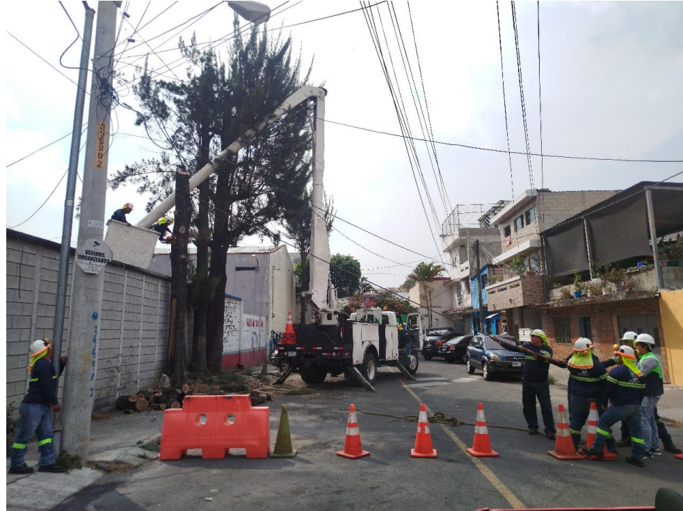
Figura 29. Tala controlada de un árbol de Casuarina spp. con muerte estructural asociada a la infección por Ganoderma spp., realizada como medida de mitigación del riesgo de caída en vía pública, en coordinación con personal operativo de la Municipalidad de Guatemala.
