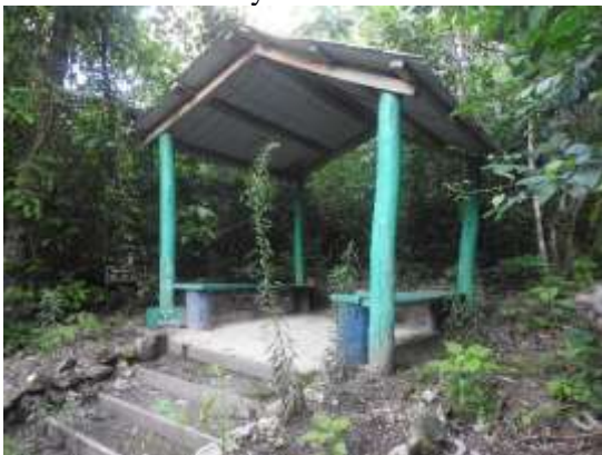
Descansaderos ubicados en los senderos
