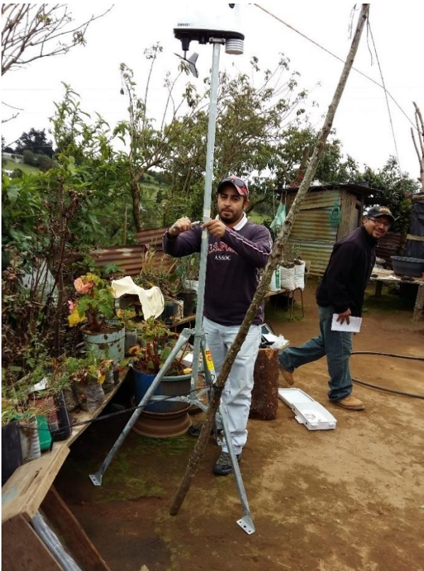
Figura 11 Instalación de estación meteorológica.
