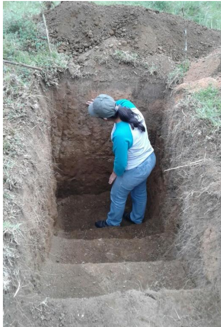
Figura 26 elaboración de calicatas.
