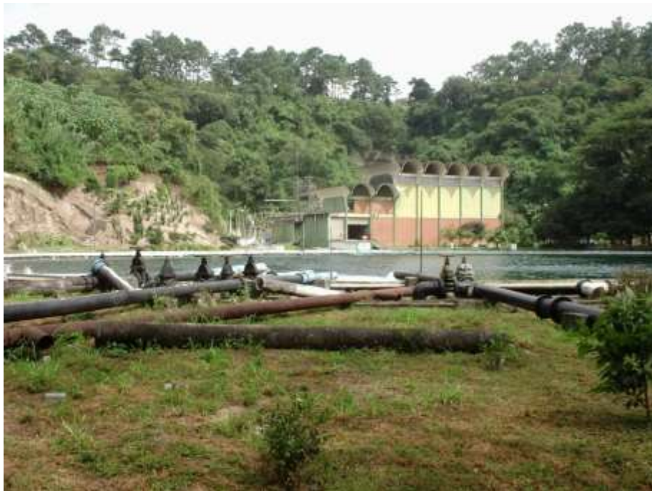
Figura 3. Tanque circular y casa de máquinas del sector Ojo de Agua.
