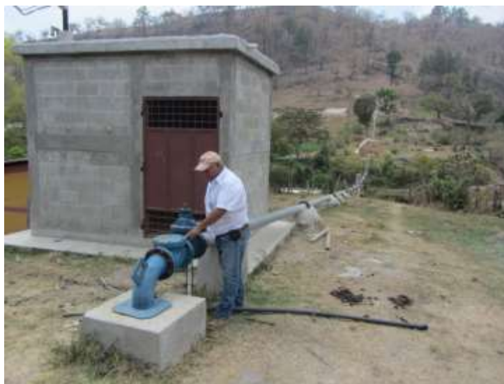
Figura 51. Brocal del pozo El Arenal en Jalapa.
