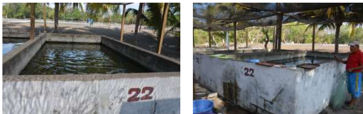
Figura 5: Infraestructura de la Fase II condiciones semi-controladas
