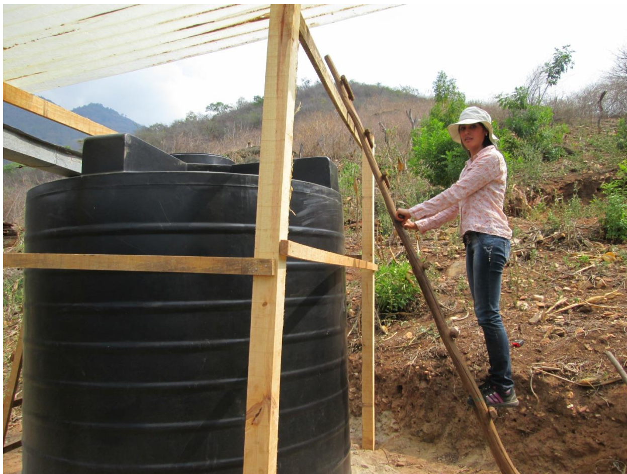
Figura 1. Reparación y mantenimiento de estructuras en el mes de abril de 2014, en la comunidad de Piedras Blancas, San Cristóbal Acasaguastlán, El Progreso.
