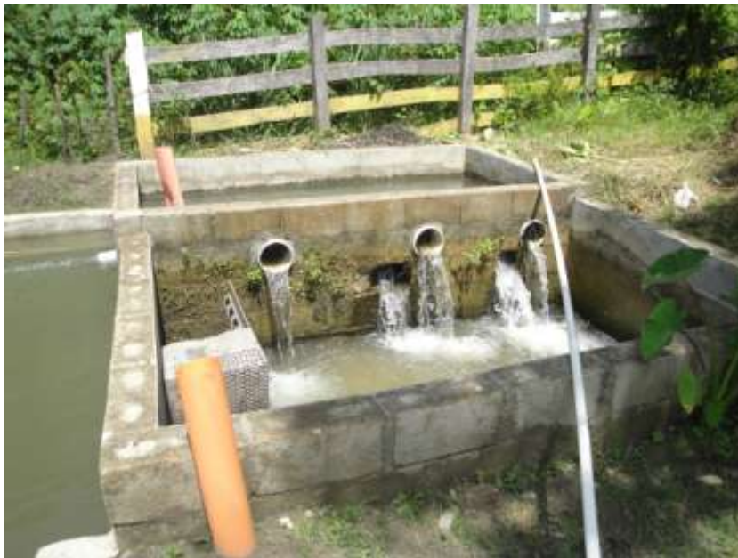
ANEXO. 08. Colocación de la tubería en la fuente de agua para abastecimiento de las mismas hacia peceras. (Trabajo de campo)
