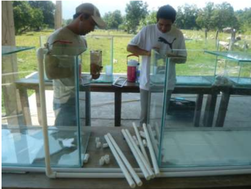
ANEXO. 15. Colocación de tubería para conducción de agua.
