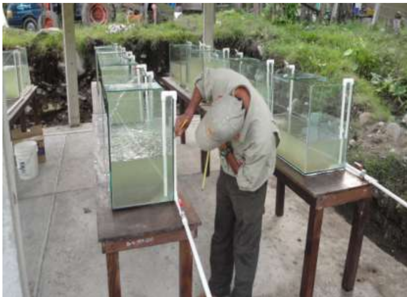
ANEXO. 16. Medición de la tubería para el desfogue de agua de las peceras.
