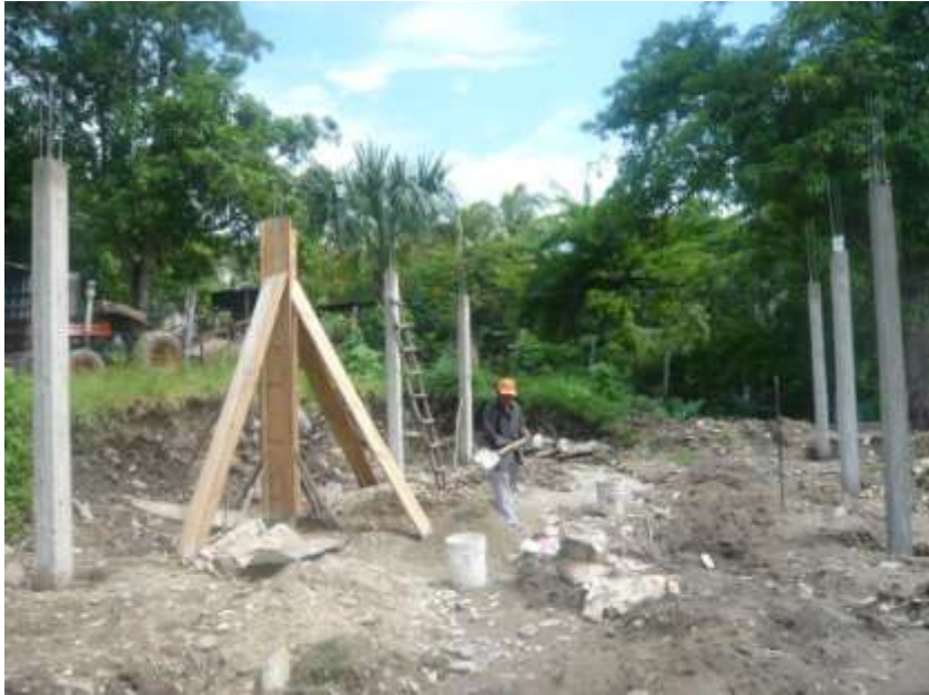
ANEXO. 05. Construcción del laboratorio experimental.
