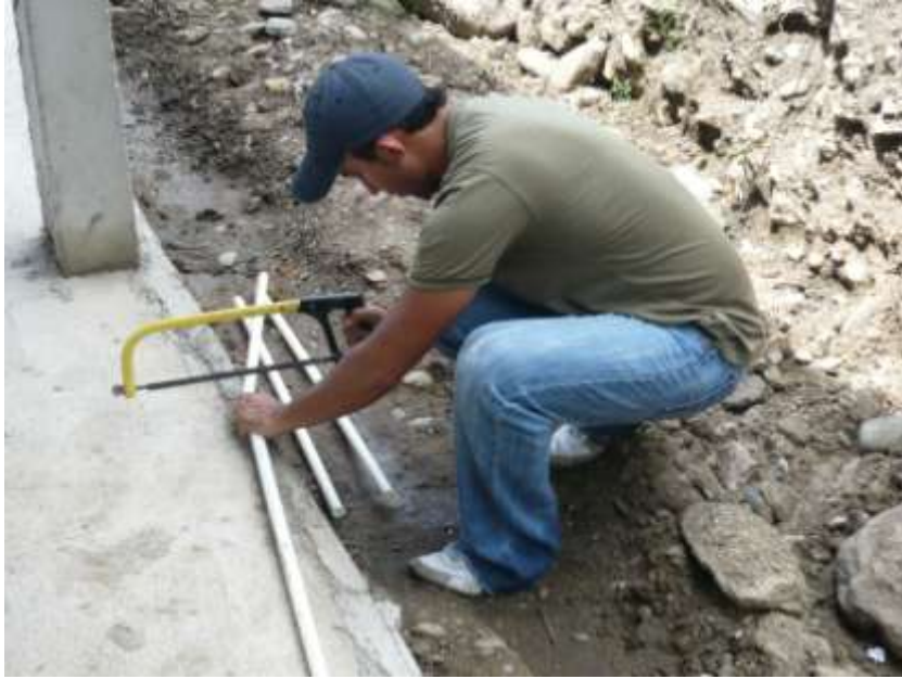
ANEXO. 17. Traslado de tubería y mesas al área de estudio. (Trabajo de campo)
