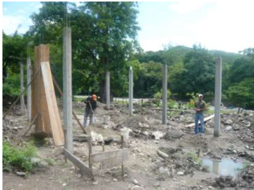
ANEXO. 06. Supervisión de la construcción del laboratorio experimental.
