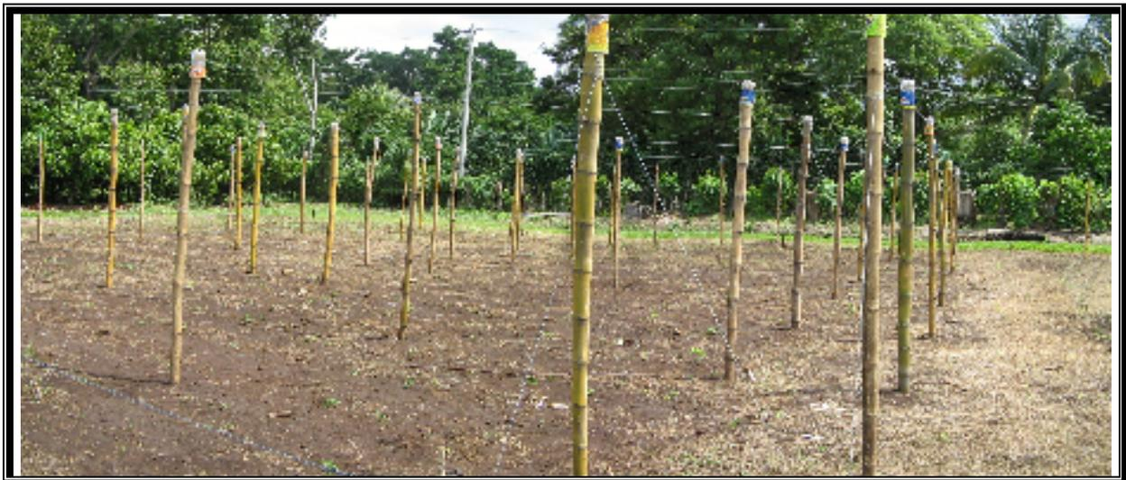
Figura 10. Colocación de postes y tensores de alambre galvanizado, para el establecimiento de umbráculos.
