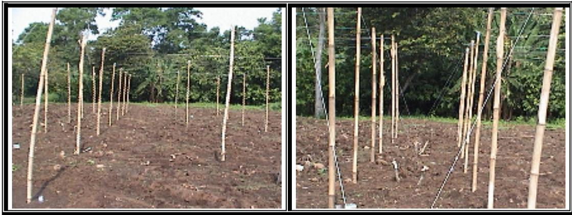
Figura 3. Colocación de postes y tensores de alambre galvanizado, para el establecimiento de umbráculos.
