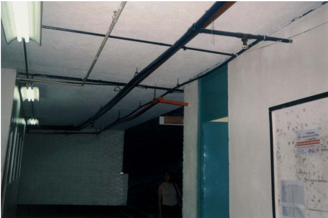
Foto No. 11. Edificio de la Facultad de Agronomía.
