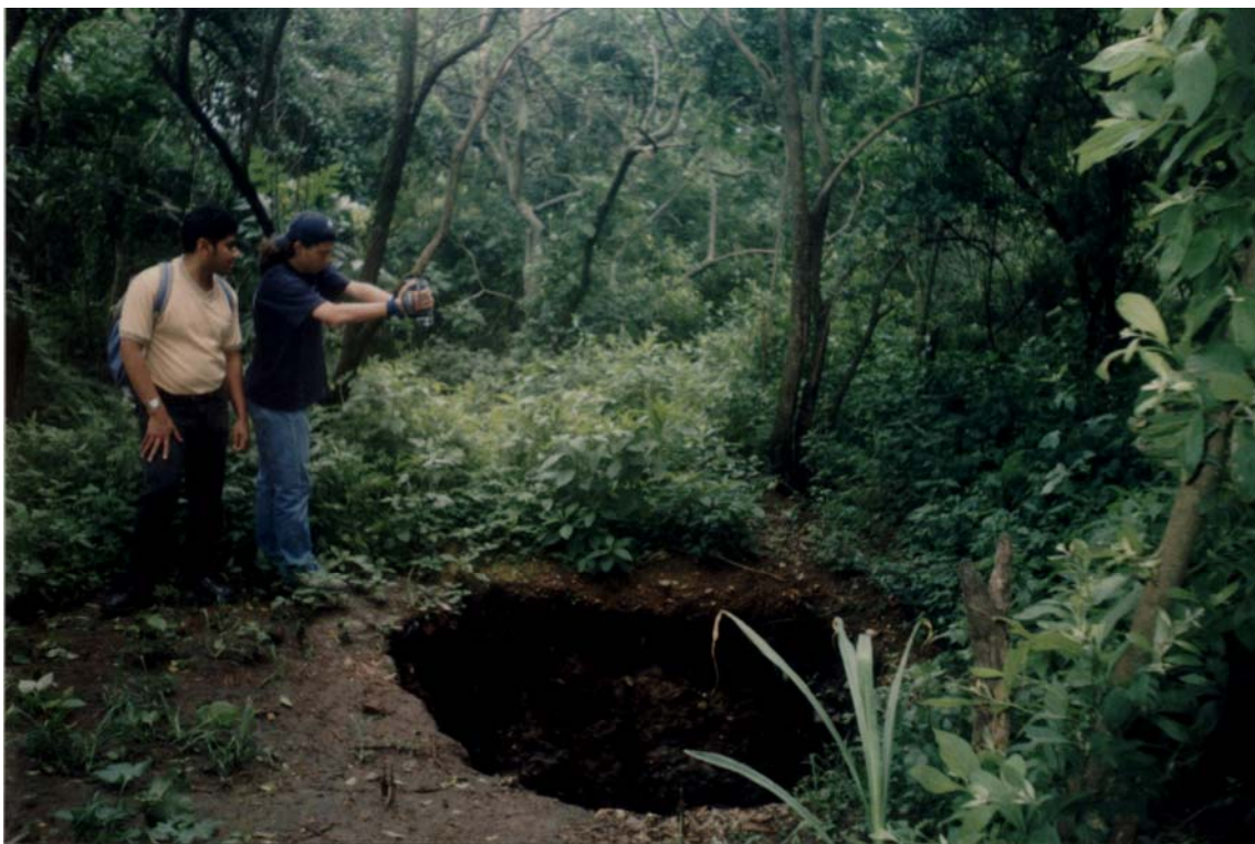
Foto No.5. Fosas sépticas de la Facultad de Veterinaria.
