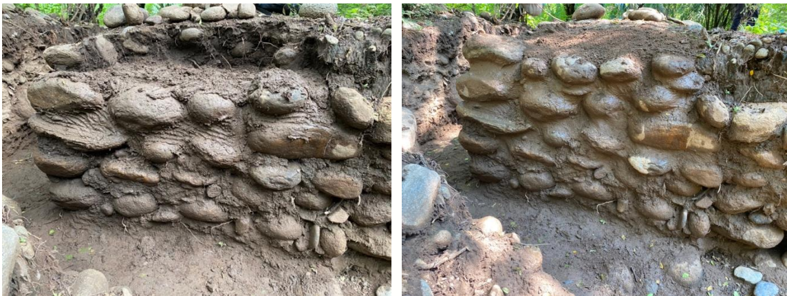
Fig. 42. A la izquierda: Segunda hilera consolidada y mezcla previo a colocar la primera hilera. A la derecha: Esquina noreste consolidada y en la parte superior monticulada. Fotografías: M. Garcia, 2024.
