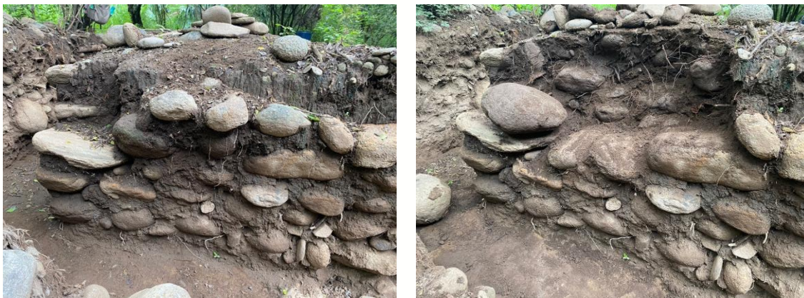
Fig. 41. A la izquierda el muro sin consolidar de la estructura C1-6, esquina noreste. A la derecha: remoción de piedras que se encontraban salidas para su reacomodamiento. Fotografía: M. Garcia, 2024.
