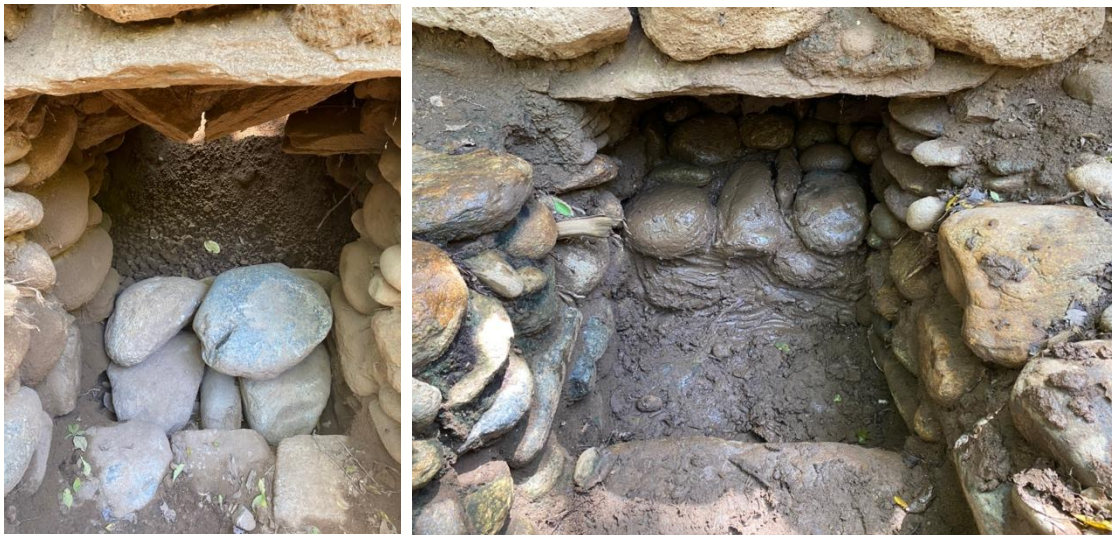
Fig. 43. Proceso de la elaboración del muro de contención para sostener el muro colapsado y la tierra del relleno dentro de la tumba 10. Fotografías: M. Garcia, 2024.
