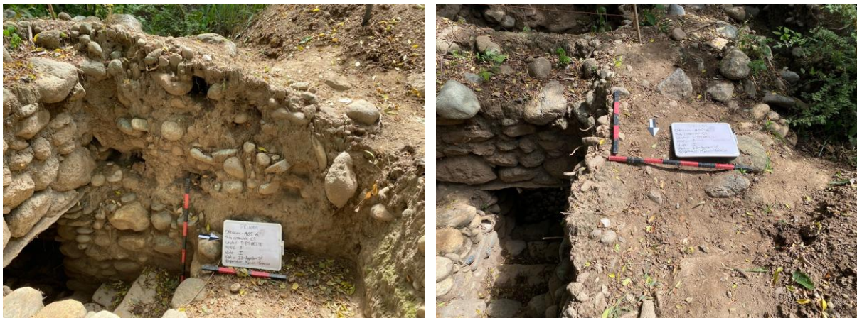
Fig. 4. Vista de la parte noroeste de la estructura C1-6 previo a su intervención con la trinchera 85 ext. O, para la liberación total del muro norte. Fotografías: M. Garcia, 2024.
