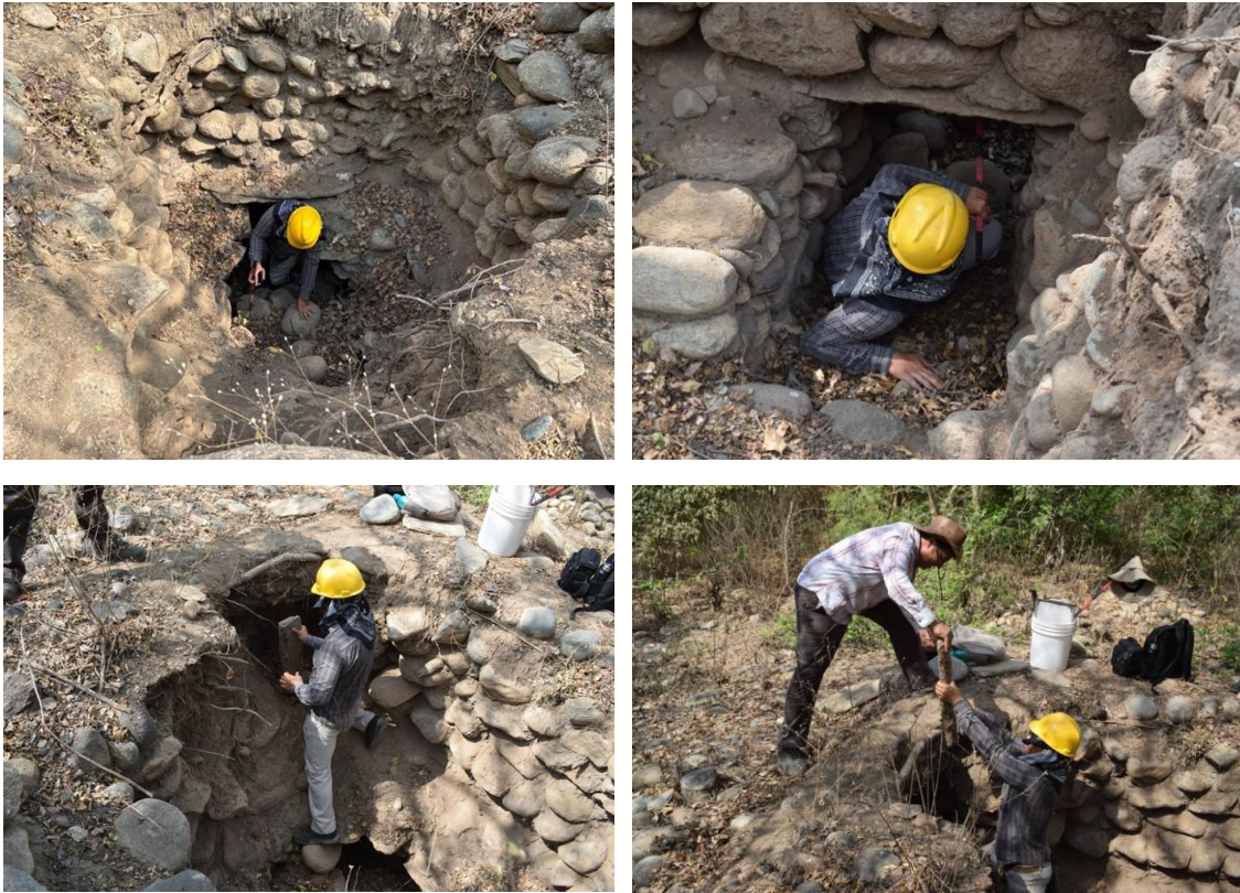
Fig. 39. Proceso de inspección e identificación de daños en la estructura C1-6 del sitio arqueológico Vega del Cobán. Fotografías: L. Romero y L. Morán, 2024
