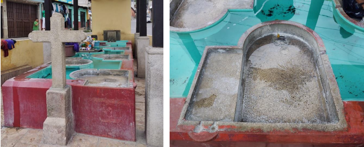
Ilustración 7. Izquierda: vista panorámica, derecha: detalle de uno de los lavaderos de la pila la Unión. Tomadas por E. Toj, 2023.
