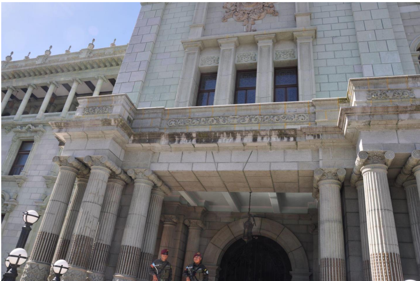
Figura 22: Detalle del entablamento del cuerpo central del Palacio Nacional de la Cultura, con presencia de líquenes, agosto 2023
