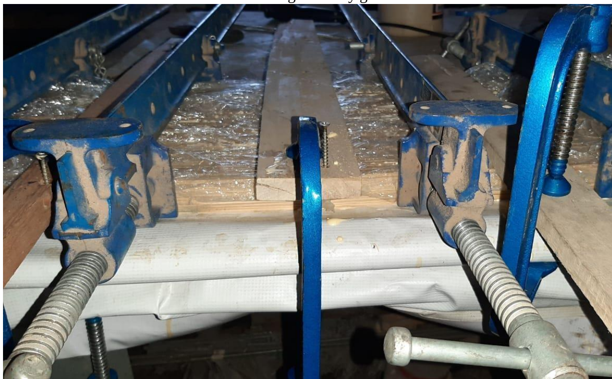
Utilizando diferentes sargentos para mantener las latillas juntas y a escuadra para conformar el tablero
