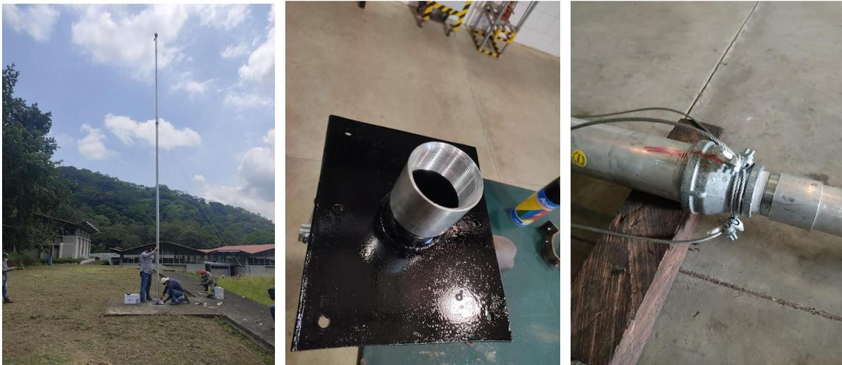
Nota: a la izquierda, instalación del mástil en el sitio designado del Instituto, al centro, base de soporte para el mástil, a la derecha, elementos de sujeción por cable de acero y reductor de tubería roscado. Elaboración propia.
