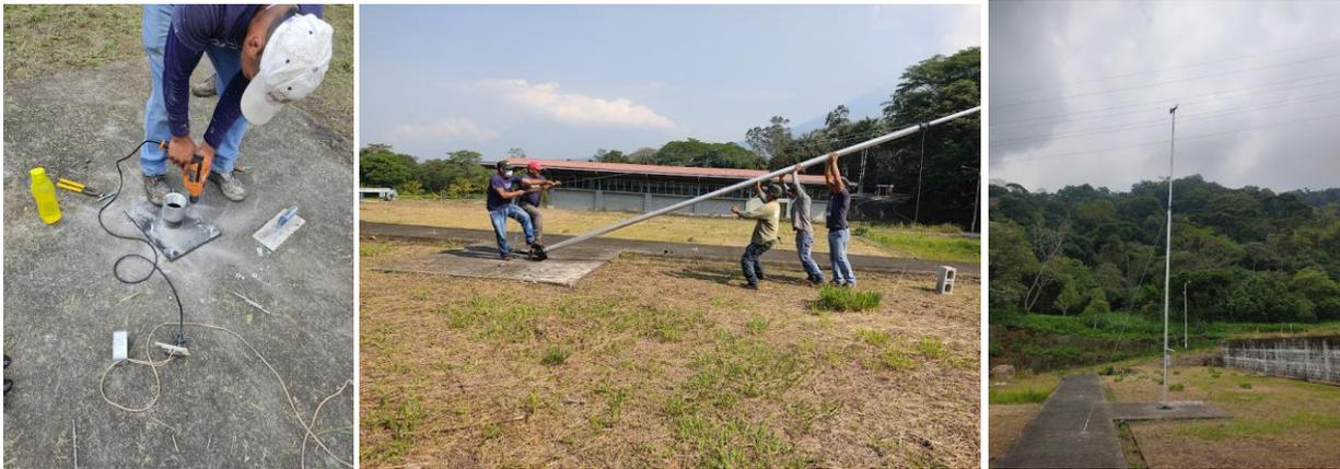
Nota: a la izquierda, instalación de pernos de expansión, al centro, montaje del mástil, a la derecha, mástil montado. Elaboración propia
