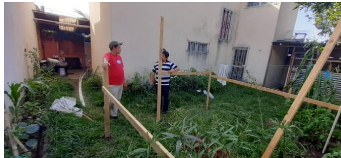
Imagen 9. Construcción del Invernadero experimental.
