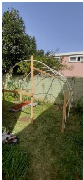
Imagen 12. Estructura del invernadero experimental finalizada
