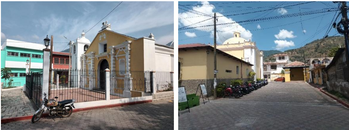
Ilustración 2. Izquierda: Vista de la iglesia de San Andrés Ceballos, San Antonio Aguas Calientes. Derecha: vista de la parte posterior de la iglesia de San Antonio Aguas Calientes, Sacatepéquez. Tomadas por Padilla, 2025.
