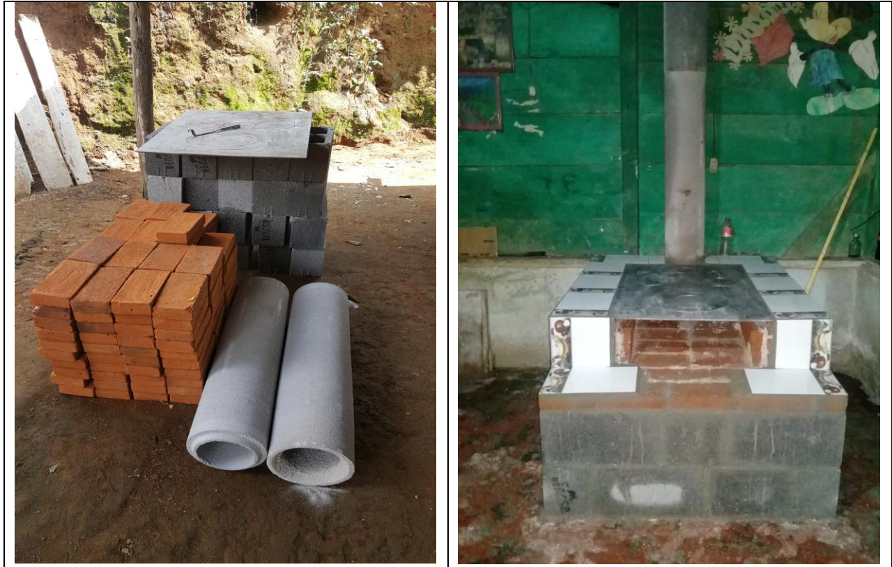
Figura 8 Materiales y prototipo de estufa mejorada DIGI-1.
