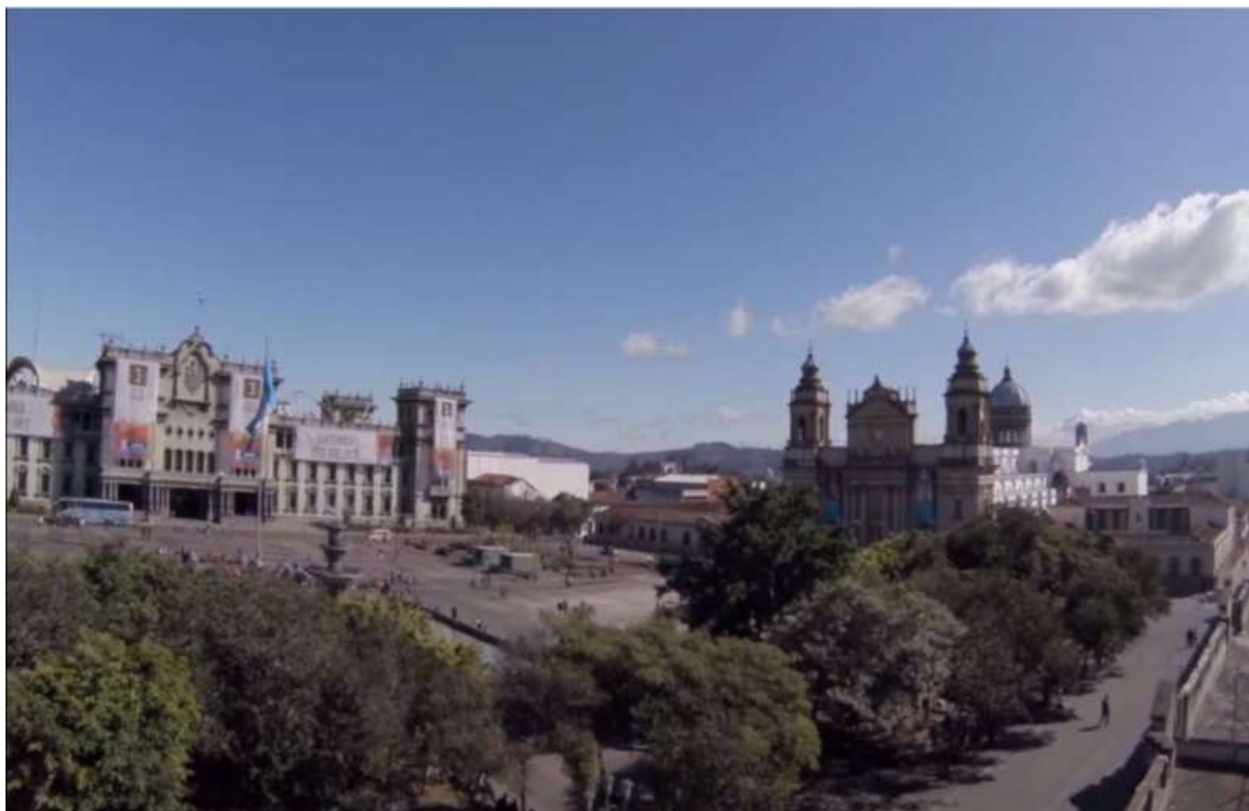
Figura 10. Plaza de la Constitución, 2015. Adaptado de “Los 220 años de nuestra catedral” [Video], por Municipalidad de Guatemala, 2015, http://digiml.maps.arcgis.com/apps/MapTour/index.html?appid=e8e1b250e6ab41baa33b27cea31f7f27
