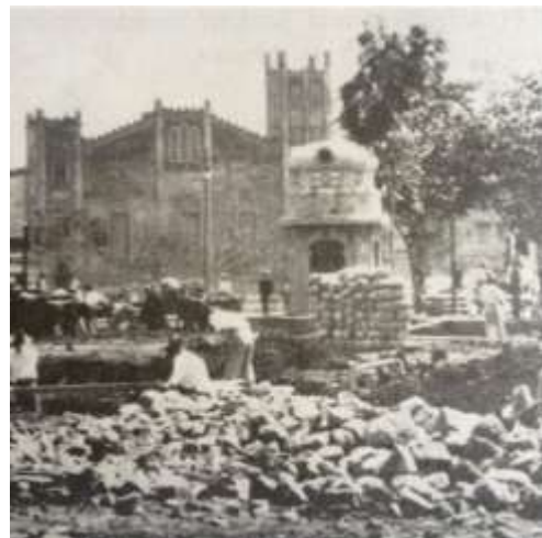
Foto 56. [1928-1930-año1929-Alcantarillado y Pavimentación]. En Historia de Guatemala en Fotografías. Recuperado de: https://www.facebook.com/Historia-De-Guatemala-En-Fotografias-356004811225756/photos/?tab=album&album_id=356016871224550
