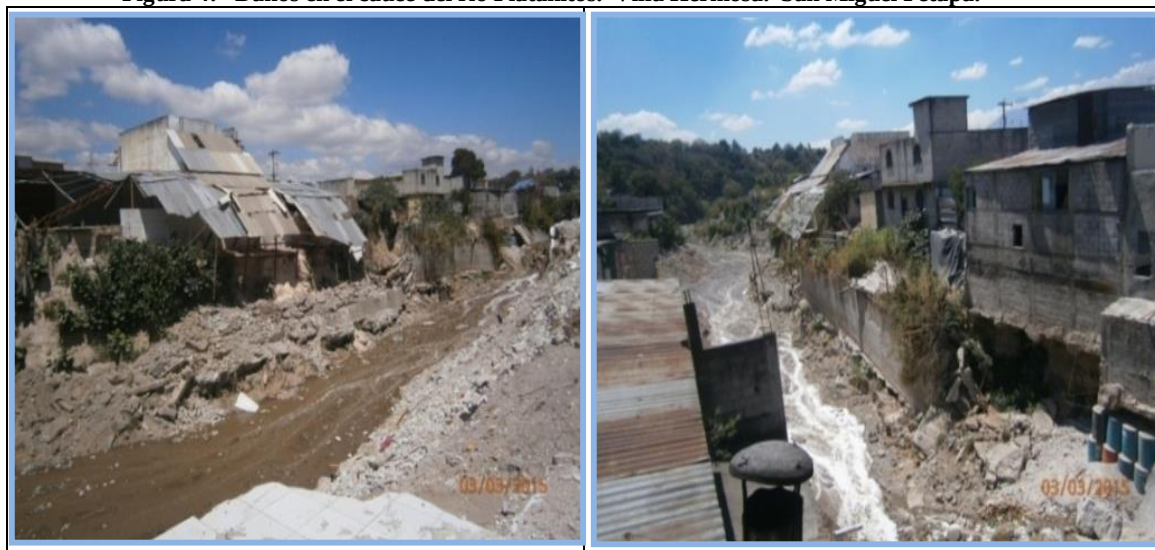
Figura 4: Daños en el cauce del río Platanitos. Villa Hermosa. San Miguel Petapa.
