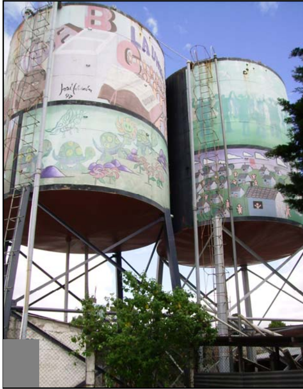
Foto de los pozos de agua de El Mezquital en los que se ha pintado murales contando la historia de la comunidad.
