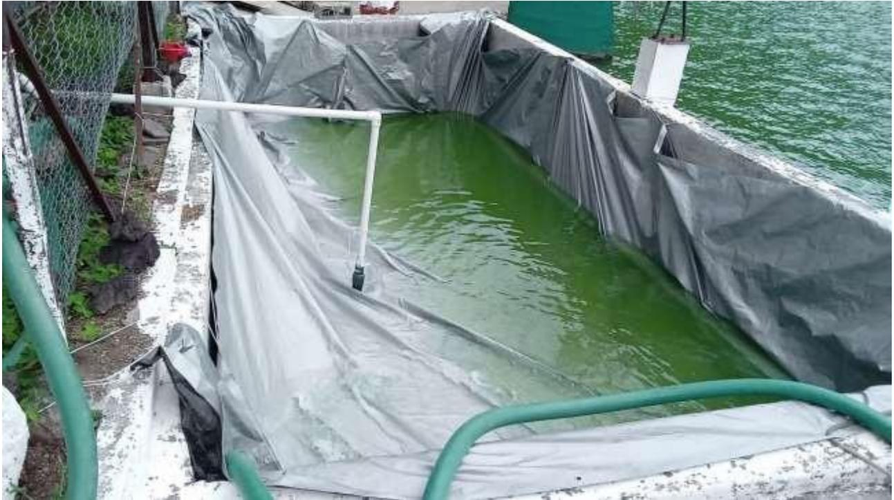
*Fotografía 6. Pileta ubicada en Estación Acuática de AMSA, con recubrimiento para evitar fuga y empezando a llenarla*
