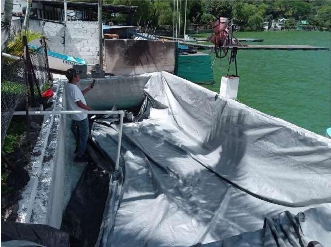
*Fotografía 4. Pileta ubicada en Estación Acuática de AMSA, principiando a colocarle recubrimiento para evitar fuga*
