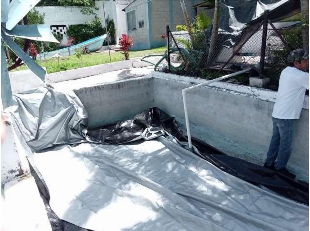
*Fotografía 5. Pileta ubicada en Estación Acuática de AMSA, colocándole recubrimiento para evitar fuga*
