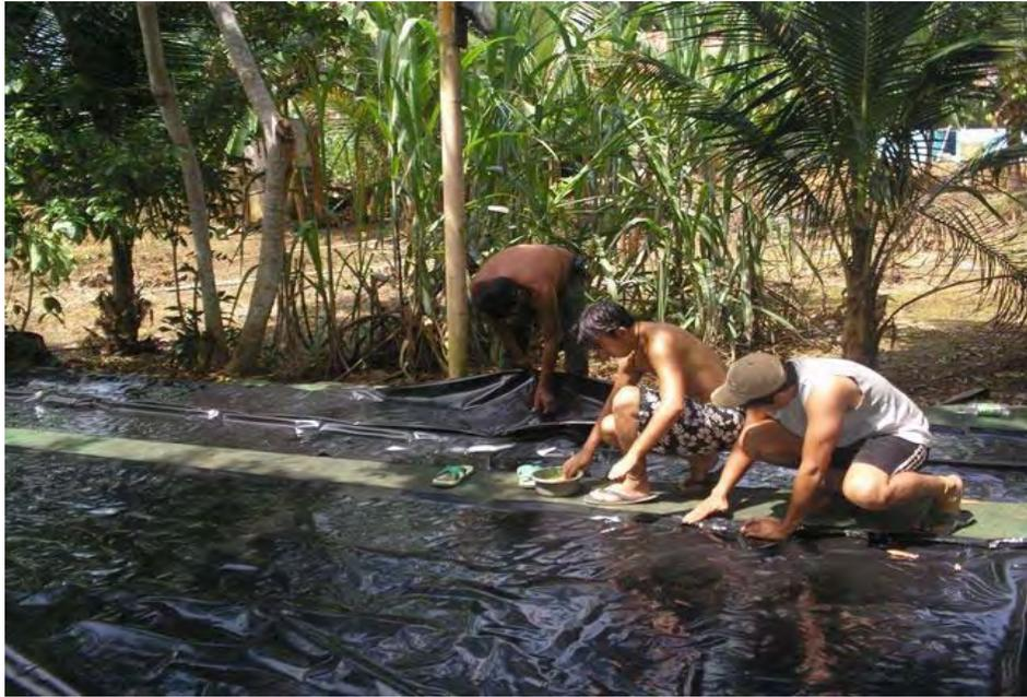
**Figura No. 5 A.** Cortado de plástico salinero para revestimiento de estanques.
