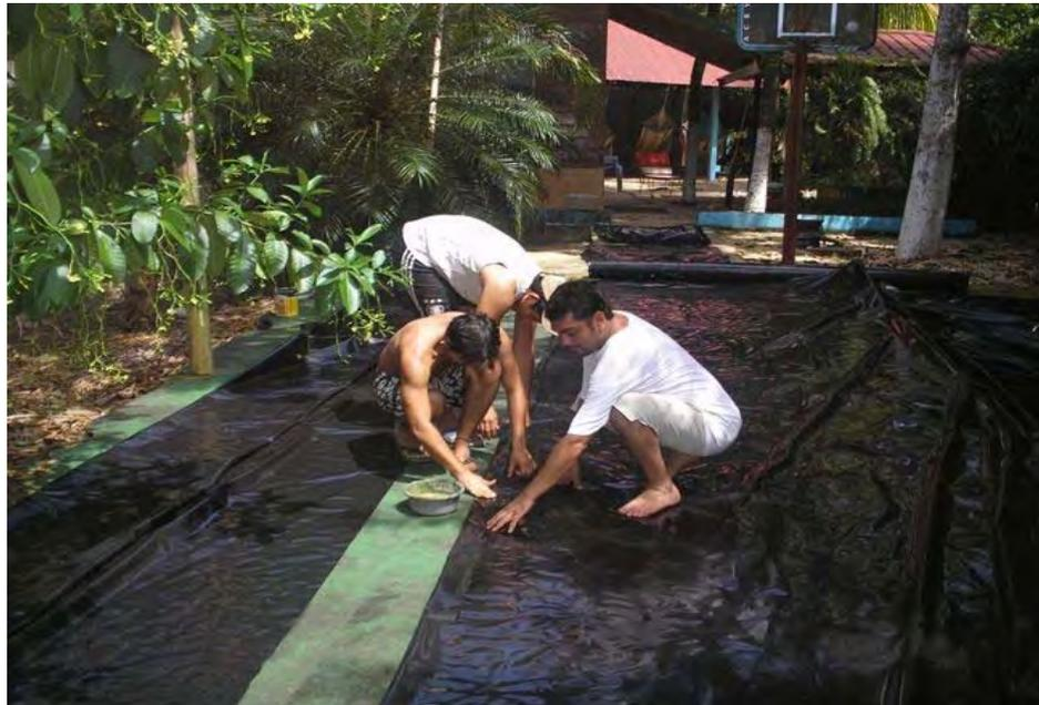
**Figura No. 6 A.** Cortado de plástico salinero para revestimiento de estanques.
