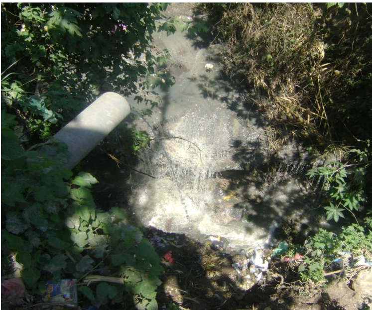
Foto No. 7: Río de aguas negras ubicado en la parte baja del asentamiento Santo Domingo “El Tuerto”.
