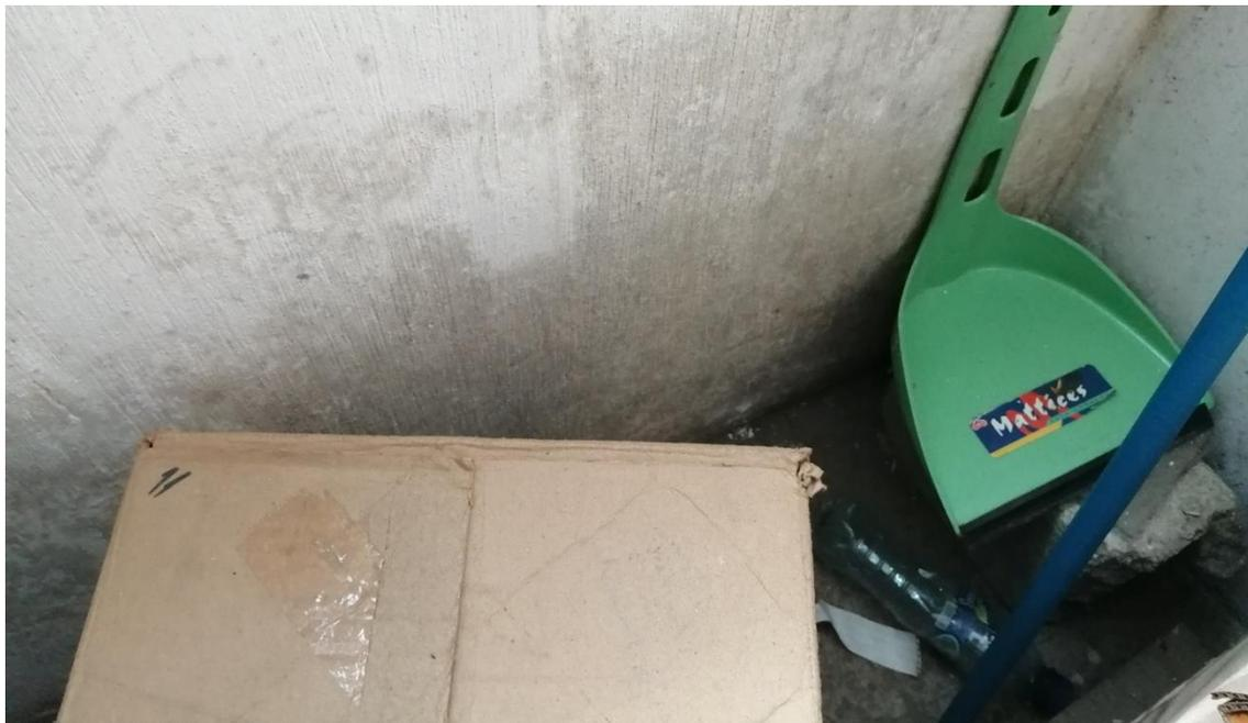
*Imágenes 22 y 23. Marcas de humedad en la parte inferior y en la pared que la sustenta evidencia la presencia de agua de lluvia que se escurre. De lo anterior, el potencial riesgo para los documentos instalados en los platos inferiores y los documentos situados en el suelo, ante la posibilidad de lluvia continua. Se advierten soluciones improvisadas para contener o intentar desviar la mayor cantidad de agua.*
