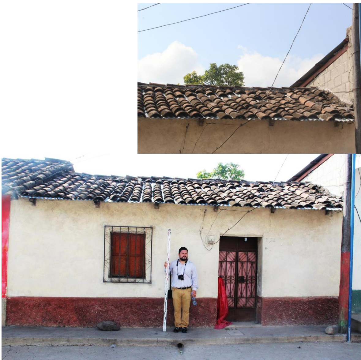
Figura 37. SJL002, vivienda con alteraciones modernas. Foto Sebastián Araujo.
