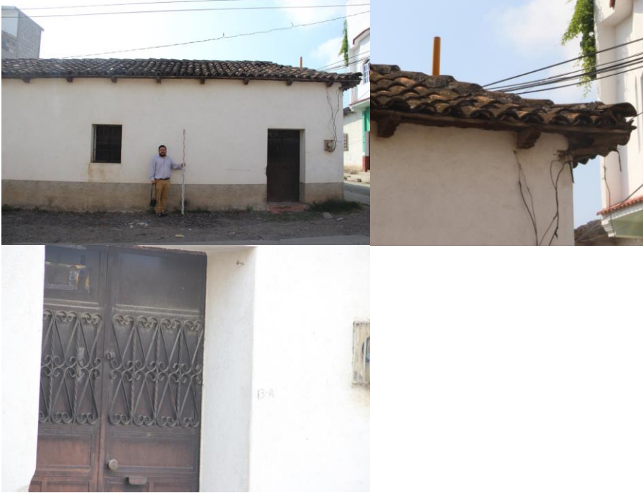
Figura 35. Vivienda SJL001, Adobe y Teja, Fotos Sebastián Araujo.
