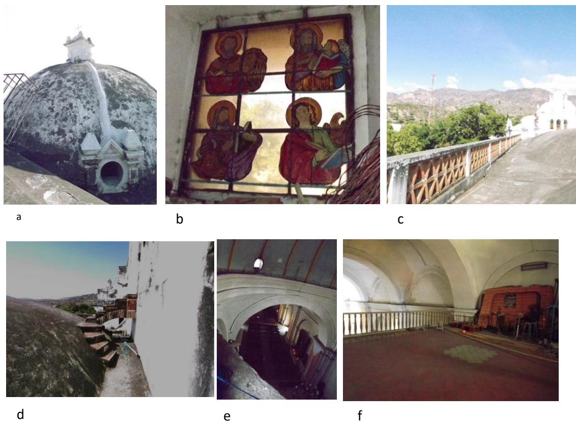
Figura 24. Detalles del Templo: a) Cúpula con remate y linternillas. b) Vitral con los cuatro evangelistas. c) Cubierta con cúpulas sin cimborio y espadaña con campanas. d) Escalinata para subir a las campanas. e) Toma desde linternilla de la cúpula principal. f) Coro alto. Fotos Ch. Martínez.
