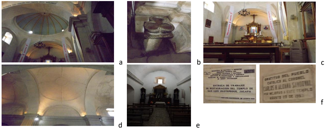
Figura 25. a) Cúpula del altar mayor, b) Recipientes para agua bendita, c) detalle del altar mayor de estilo renacentista, d) cúpulas sin cimborio apoyados sobre arcadas de la bóveda del techo del templo, e) Capilla de la Virgen del Carmen, f) Placas de las diversas restauraciones realizadas. Fotos Ch. Martínez
