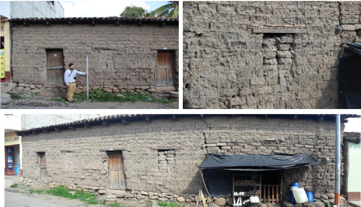
Figura 44. Vivienda de adobe con daños visibles en la fachada.
