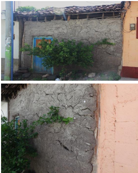
Figura 50. Vivienda de Bajareque, nótese la paja en el barro como desgrasante y aglutinante a la vez. Foto Sebastián Aruajo, Ch. Martínez.
