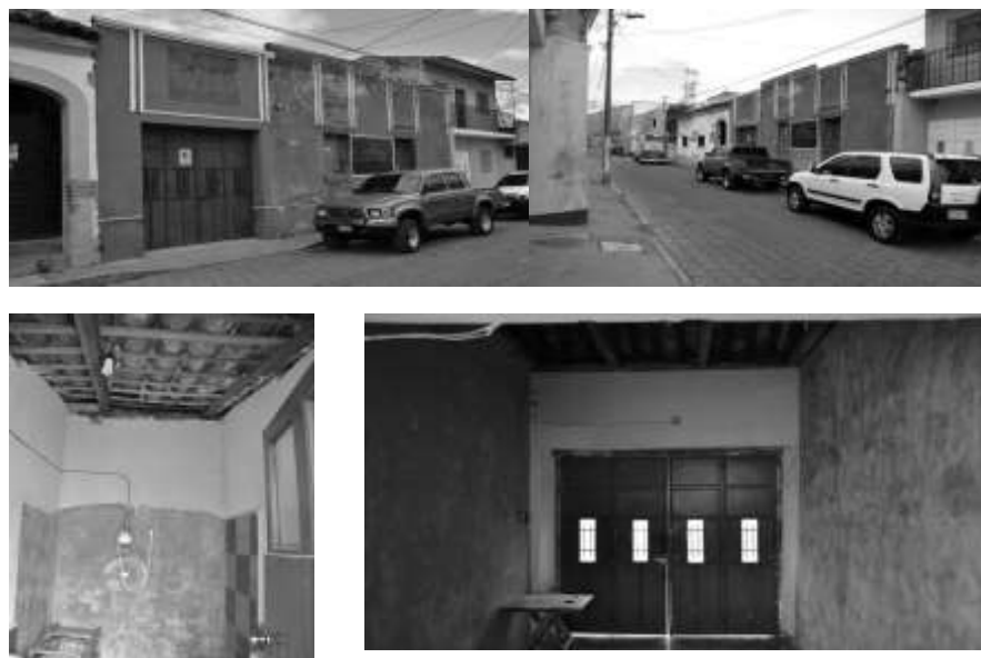
Imagen 56 Democracia 007, detalles del interior, nótese e l techo de teja y el espacio del zaguán.
