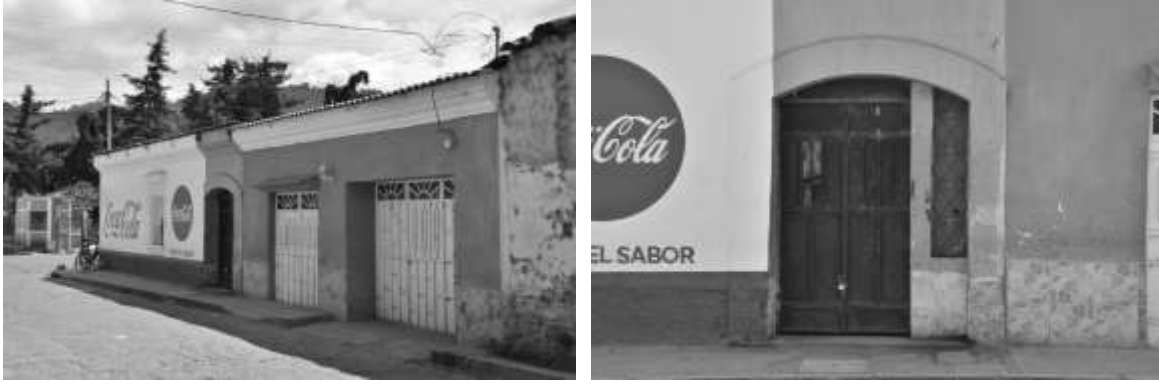
Imagen 88 Detalles de las modificaciones a la propiedad.
