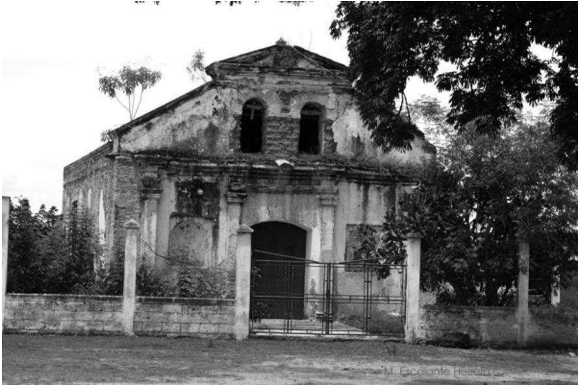
Imagen 122 Capilla de la Concepción, fotografía de 2010, tomada por Marco Escalante.
