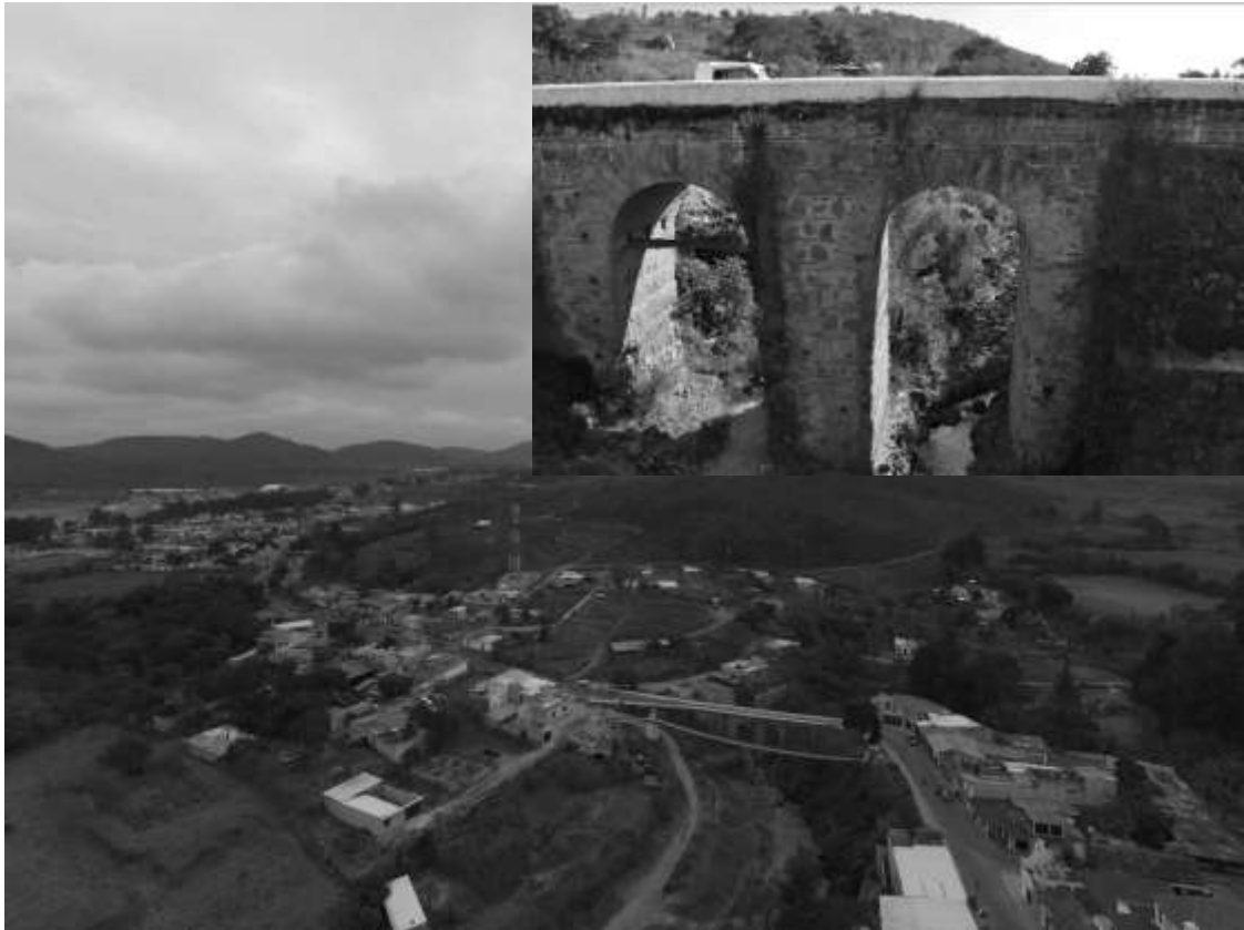
Imagen 35 Puente de Chipilapa, vista aérea e inserto, detalle de los arcos.
