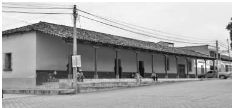
Imagen 113 San Pedro Pinula 036, construcción de portal.
