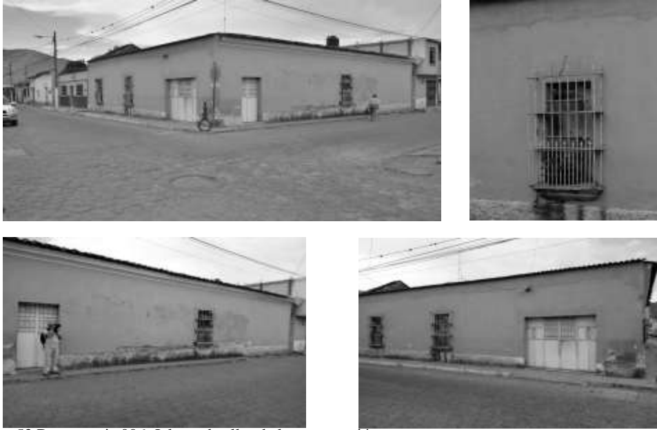
Imagen 53 Democracia 006, Jalapa, detalles de la construcción.
