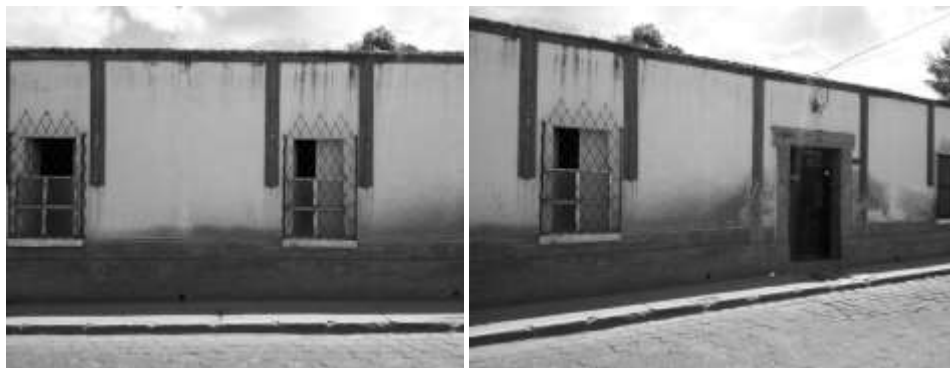
Imagen 84 Democracia 026, nótese el detalle de los balcones de metal.
