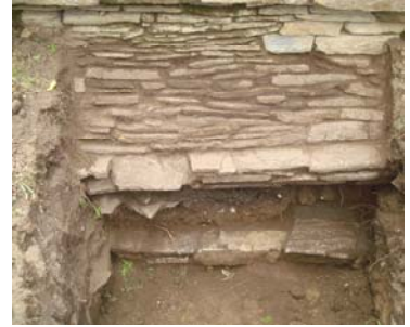
Fotografía 9. Edificio 13 grupo A
