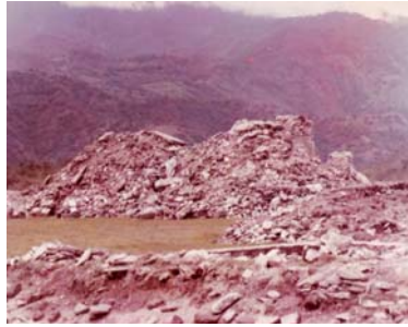
Fotografía 3. Edificio B 3 estado después del terremoto de 1976 Fuente: Alfonso Girón
