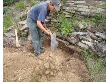
Fotografía 6. Inicio de excavación de la cala 1 Edificio Ax1
