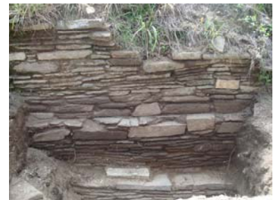
Fotografía 11. detalle de cala Edificio 13
