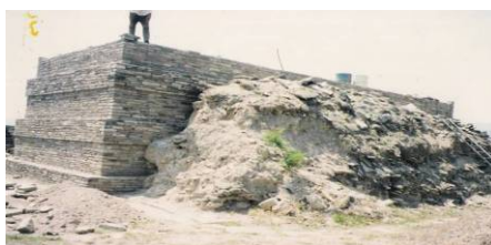
Fotografía 1. Edificio A2 después del terremoto de 1976 Fuente: Alfonso Girón
