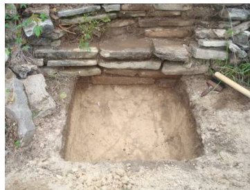
Fotografía 8. Cala 2 Edificio Ax1 concluida
