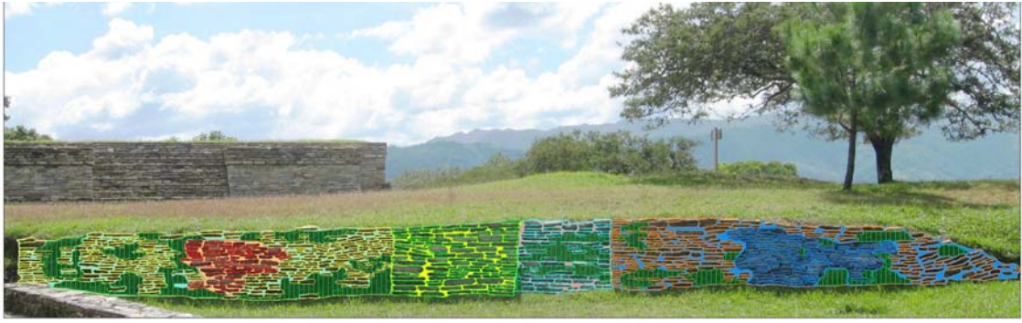
Fotografía 17. Muro de contención
