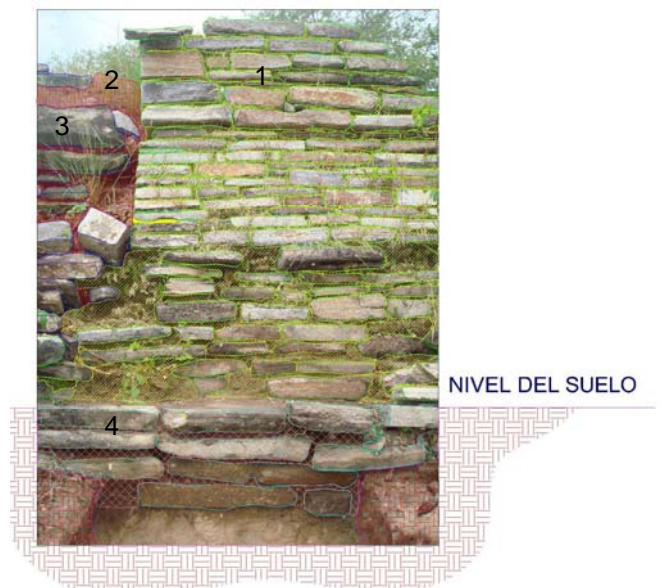
Fotografía 13. Extremo sur del edificio A x 1 paramento oriente
