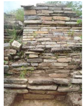
Fotografía 7. Cala 2 Edificio A x 1
