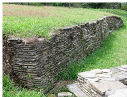
Fotografía 16. Detalle extremo norte de muro de contención Fuente: Betzabé Cruz 2010
