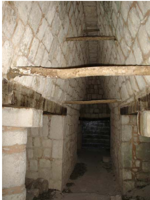
Figura 34. Combinación de tipos arquitectónicos para techos. Bóveda y techo plano permiten amplitud interna del recinto en Chichén Itzá (Foto J. A. Valdés).
