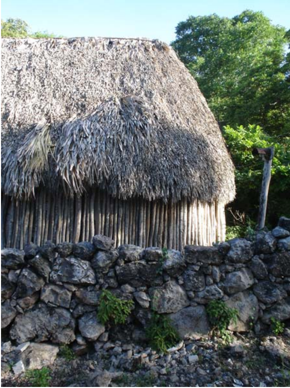
Figura No. 15: Materiales de construcción en la arquitectura doméstica.
