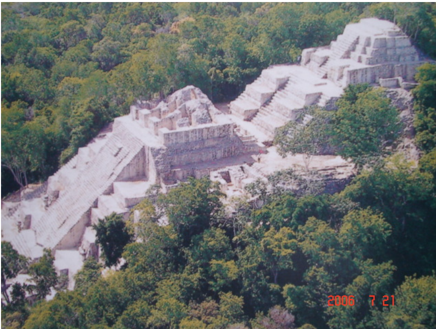
Figura No.12: Vista de los edificios mayores de Calakmul.
