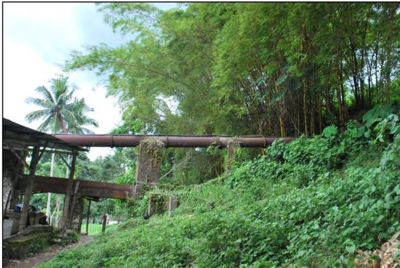
Fotografía 2 Acueducto que sostiene el canal cerrado (tubo) para el procesamiento de café, así como el que se dirige al cuarto de rueda hidráulica y que se empleó para panela.
