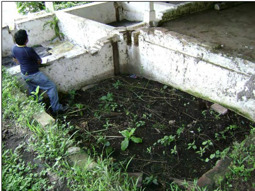
Fotografía 2. Tanque de café vado. Vista: isométrico posterior izquierdo.
