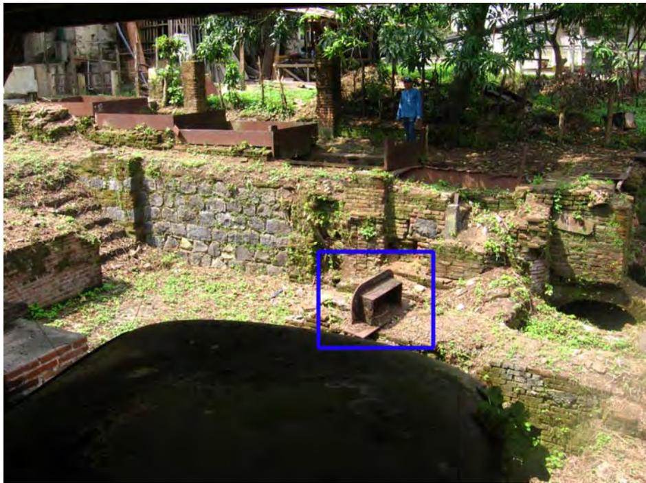
Fotografía 4. Subsistema de Cocción. Compuerta de Ornalla y Recinto de Moldaje.
