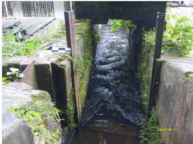
Fotografía 5. Guías de compuerta de control de caudal.
