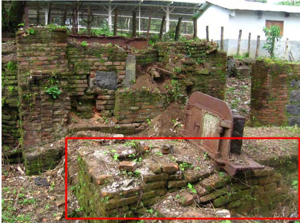
Fotografía 1. Subsistema de Cocción. Recinto de Puntera #2 y Compuerta de Ornalla.
