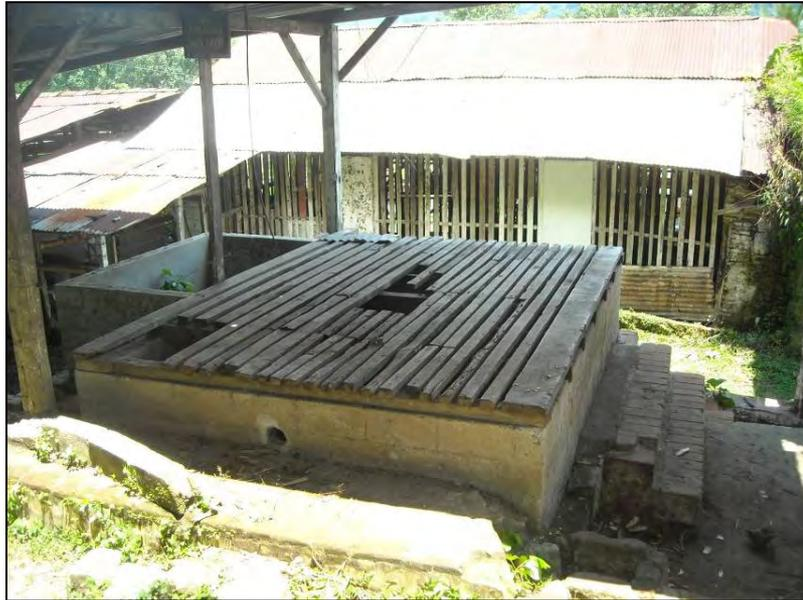
Fotografía 1. En la parte frontal se observa el recinto donde se depositaba el café en fruto para iniciar su limpieza por medio de un sifón. En su parte posterior aparece el tanque para café de segunda.
