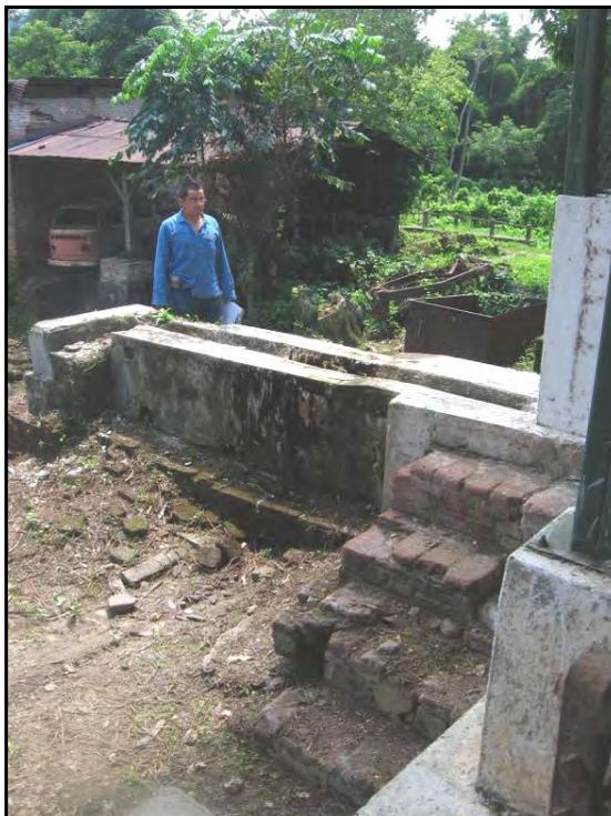
Fotografía 2. Otros tramos del canal en donde se muestra la estructura que le soporta.
