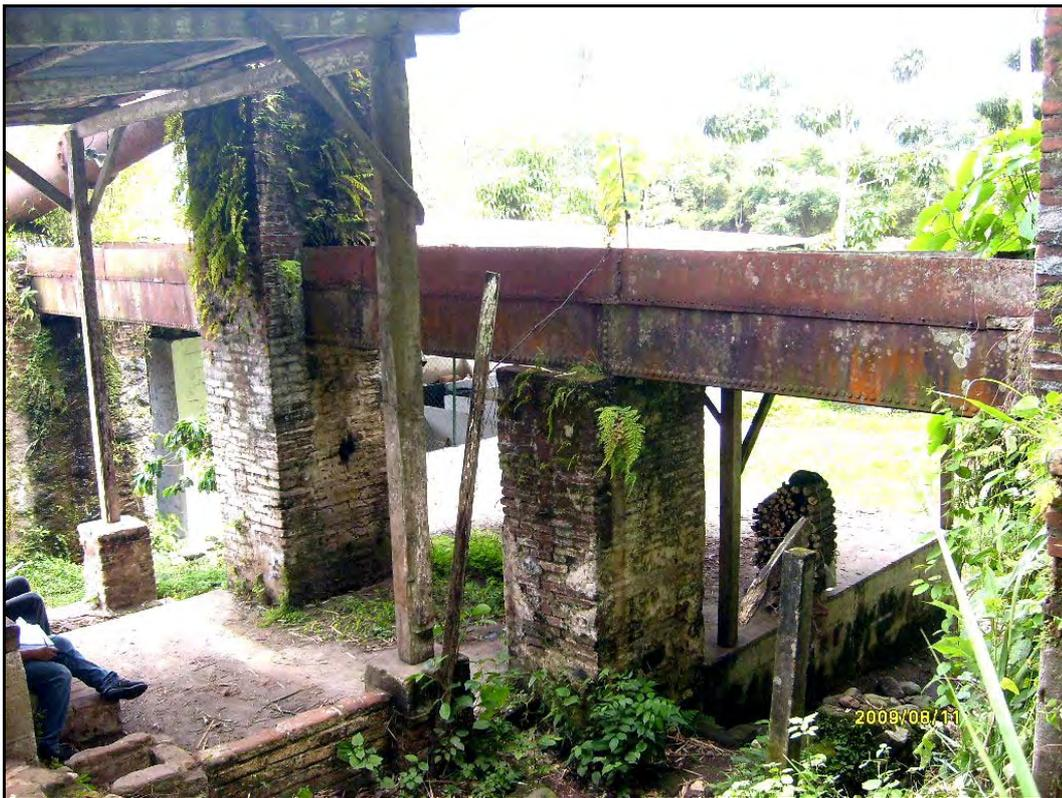
Fotografía 3. Canal metálico que transporta agua hacia la rueda hidráulica.
