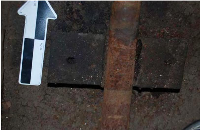
Fotografía 3. Bloque de madera que separaba el eje de una columna de concreto.
