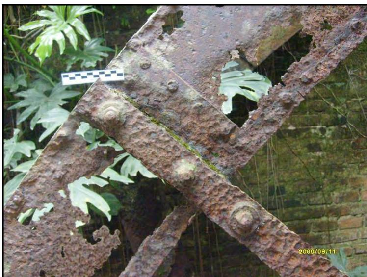
Fotografía 2. Muestra una sección lateral de la rueda hidráulica en donde es posible apreciar las formas en que fue ensamblada la misma y su estado de conservación.
