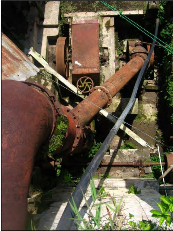
Fotografía 3 Punto donde inicia su descenso y bifurcación el canal cerrado (tubo) para concluir en el área de turbinas.
