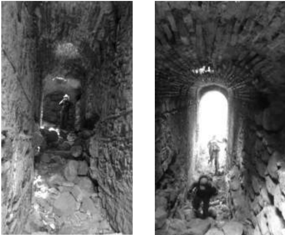
Figura 44 Izquierda vista desde el exterior al interior de la construcción. Derecha vista desde el interior al exterior. Ch. Martínez
