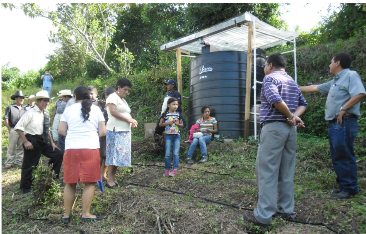
Figura 10. Instalación de tubería de Pvc y filtros del sistema de riego por goteo en Palencia, Guatemala
