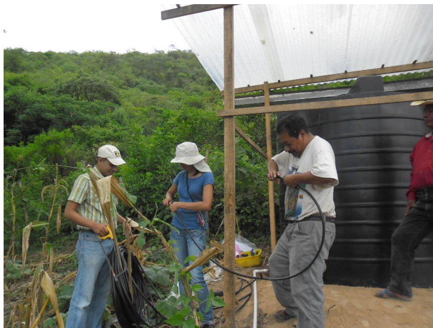
Figura 7. Instalación de tubería de Pvc y filtros del sistema de riego por goteo en Comunidad El Tempisque, Salamá, Baja Verapaz
