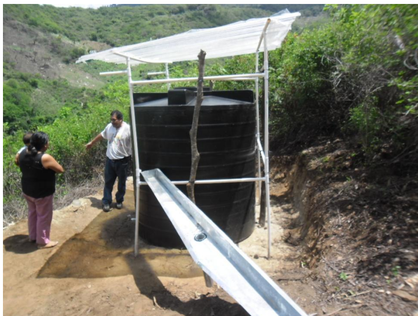
Figura 4. Instalación de estructura de captación y tanque de almacenamiento en la comunidad de Piedras Blancas, San Cristóbal Acasaguastlan, El Progreso
