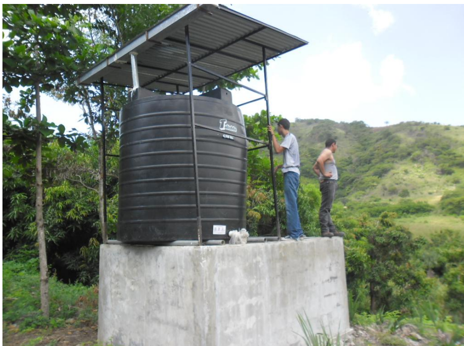
Figura 5. Instalación de estructura de captación y tanque de almacenamiento en la comunidad de Cruz del Valle, San Cristóbal Acasaguastlan, El Progreso
