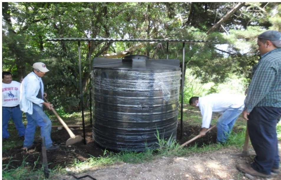
Figura 9. Instalación de estructura de captación y tanque de almacenamiento en el CEDA, Facultad de Agronomía, Universidad de San Carlos de Guatemala
