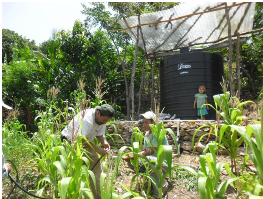
Figura 3. Instalación de estructura de captación y tanque de almacenamiento en la comunidad de San Luis Buena Vista, San Cristóbal Acasaguastlan, El Progreso
