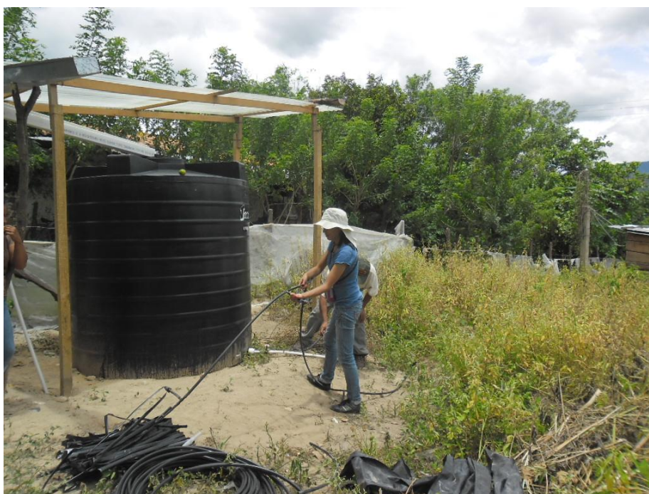
Figura 6. Instalación de tubería de Pvc y filtros del sistema de riego por goteo en Comunidad El Tunal, Salamá, Baja Verapaz
