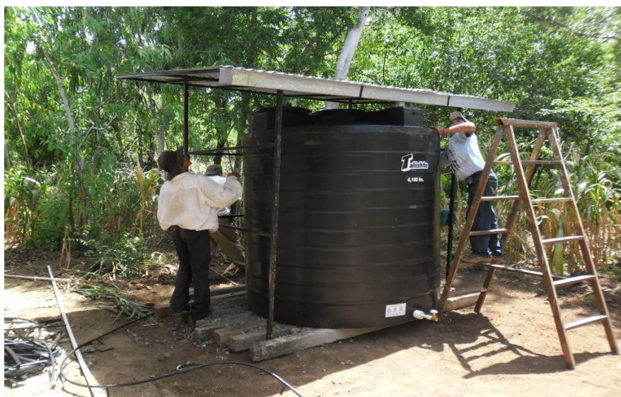
Figura 8. Instalación de estructura de captación y tanque de almacenamiento, Estación El Oasis, Estanzuela, Zacapa
