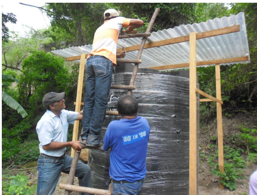
Figura 2. Instalación de estructura de captación y tanque de almacenamiento en la comunidad de El Obraje, El Progreso
